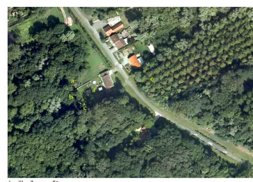
Position des 5 édifices sur une photographie aérienne de 2009 Phot. Jean-Marc Ramette IVR32_20176200332NUCA
