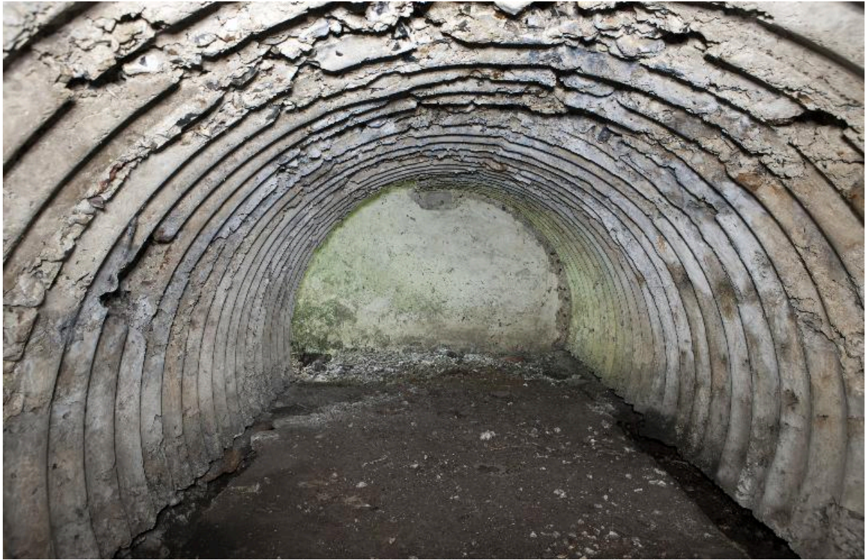
Casemate b) : Intérieur de l'abris
