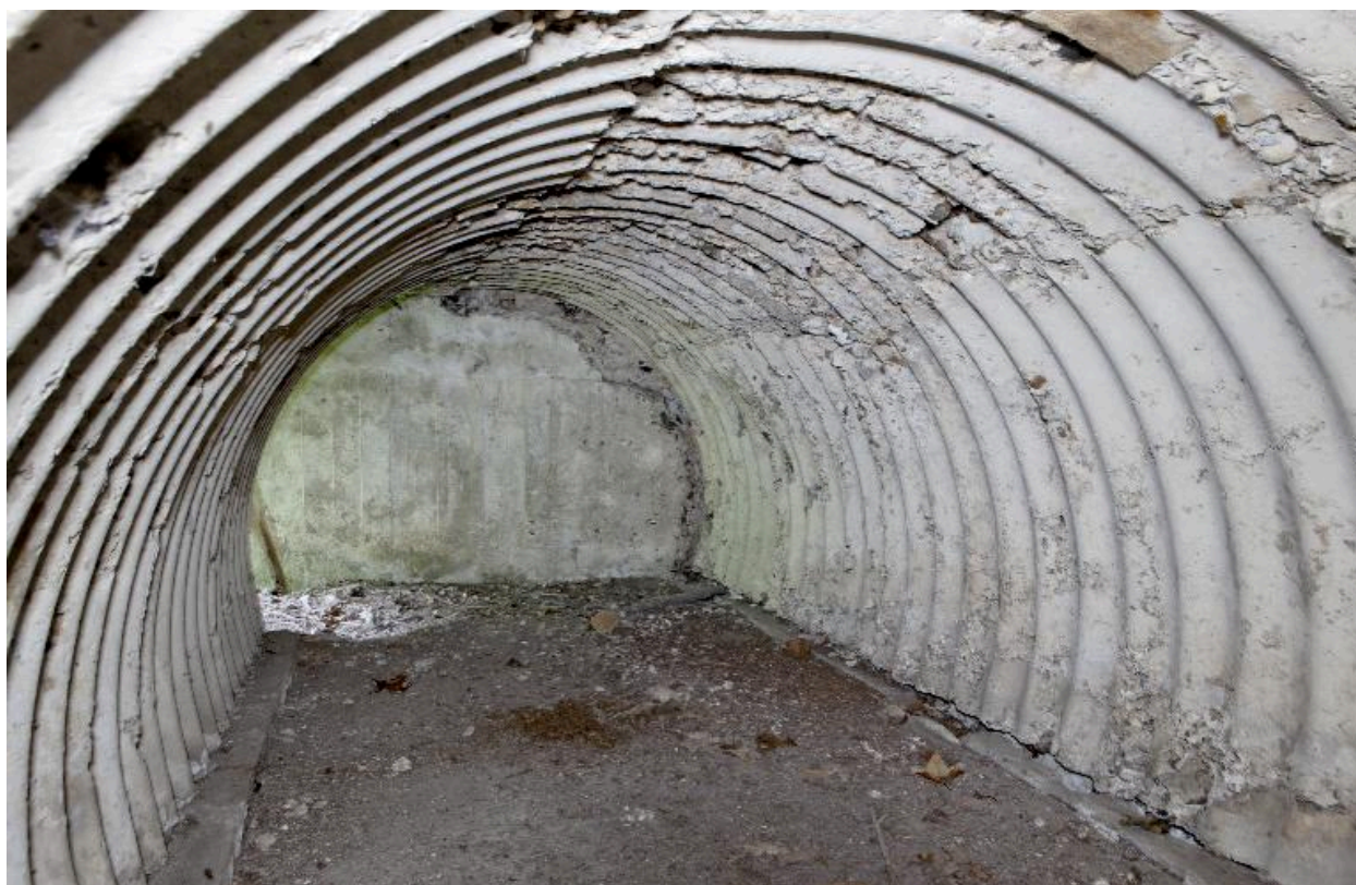
Casemate c) : Vue intérieure
