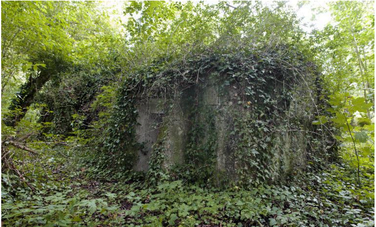
Casemate c) : Vue générale
