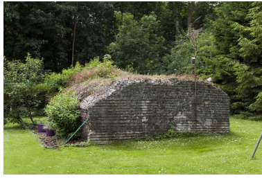
Casemate d) : Vue de trois-quarts vers le sud Phot. Jean-Marc Ramette IVR31_20146203011NUCA
