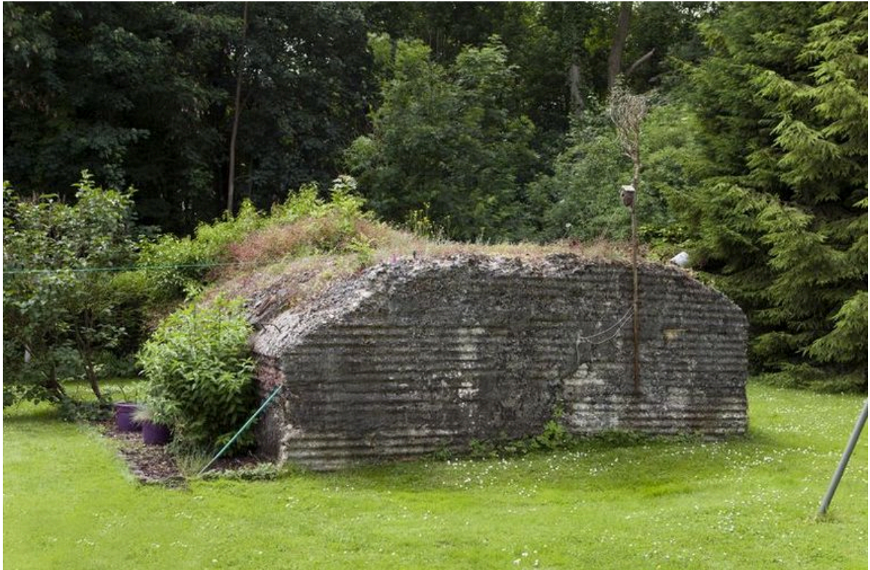
Casemate d) : Vue de trois-quarts vers le sud
