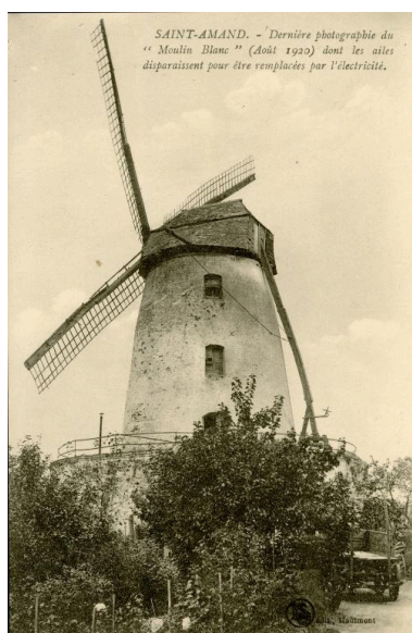
Vue générale du moulin du quartier du Moulin Blanc, existant encore aujourd'hui, carte postale sans date (Médiathèque de Saint-Amand-les-Eaux). IVR31_20155908032NUCA
