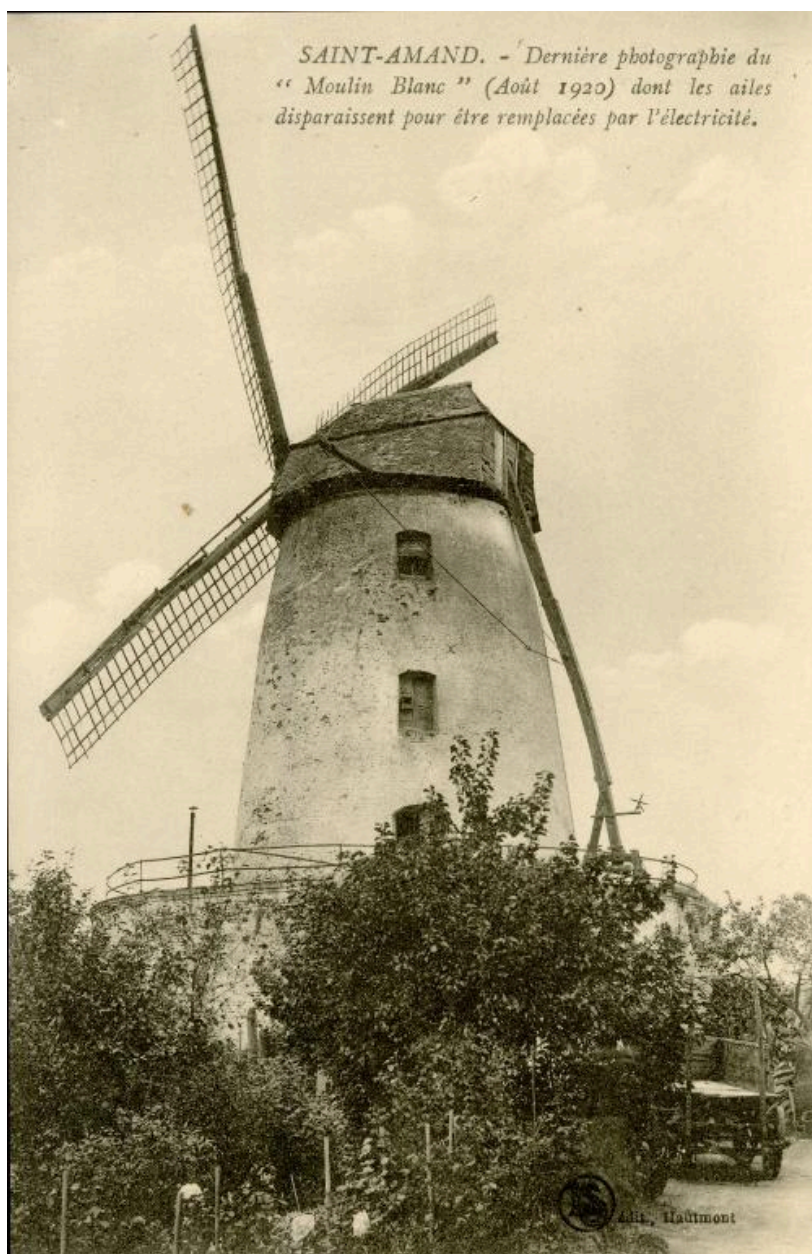
Vue générale du moulin du quartier du Moulin Blanc, existant encore aujourd'hui, carte postale sans date (Médiathèque de Saint-Amand-les-Eaux).
