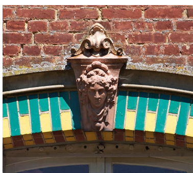
Détail de la figure en agrafe ornant la fenêtre de la façade sur cour. Phot. Thierry Lefébure IVR22_20138000187NUC2A
