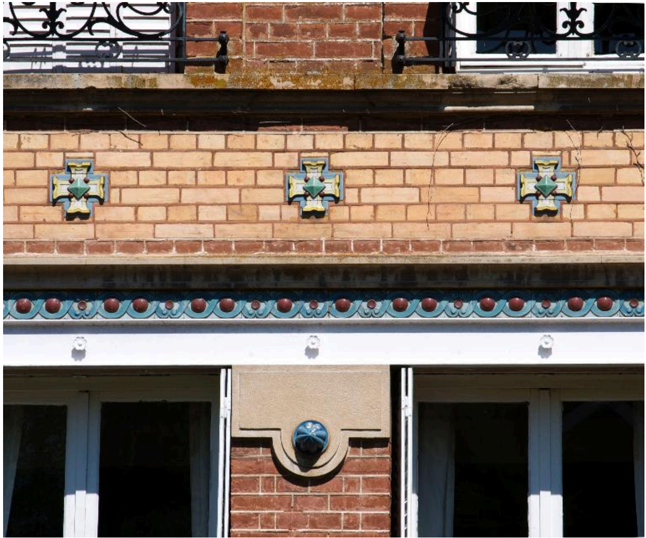
Détail du bandeau de séparation de niveau, orné de céramiques vernissées.
