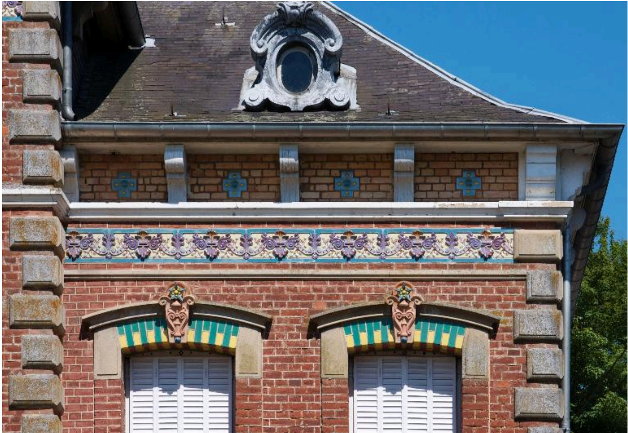
Détail de la frise de céramique vernissée de la façade sur cour.
