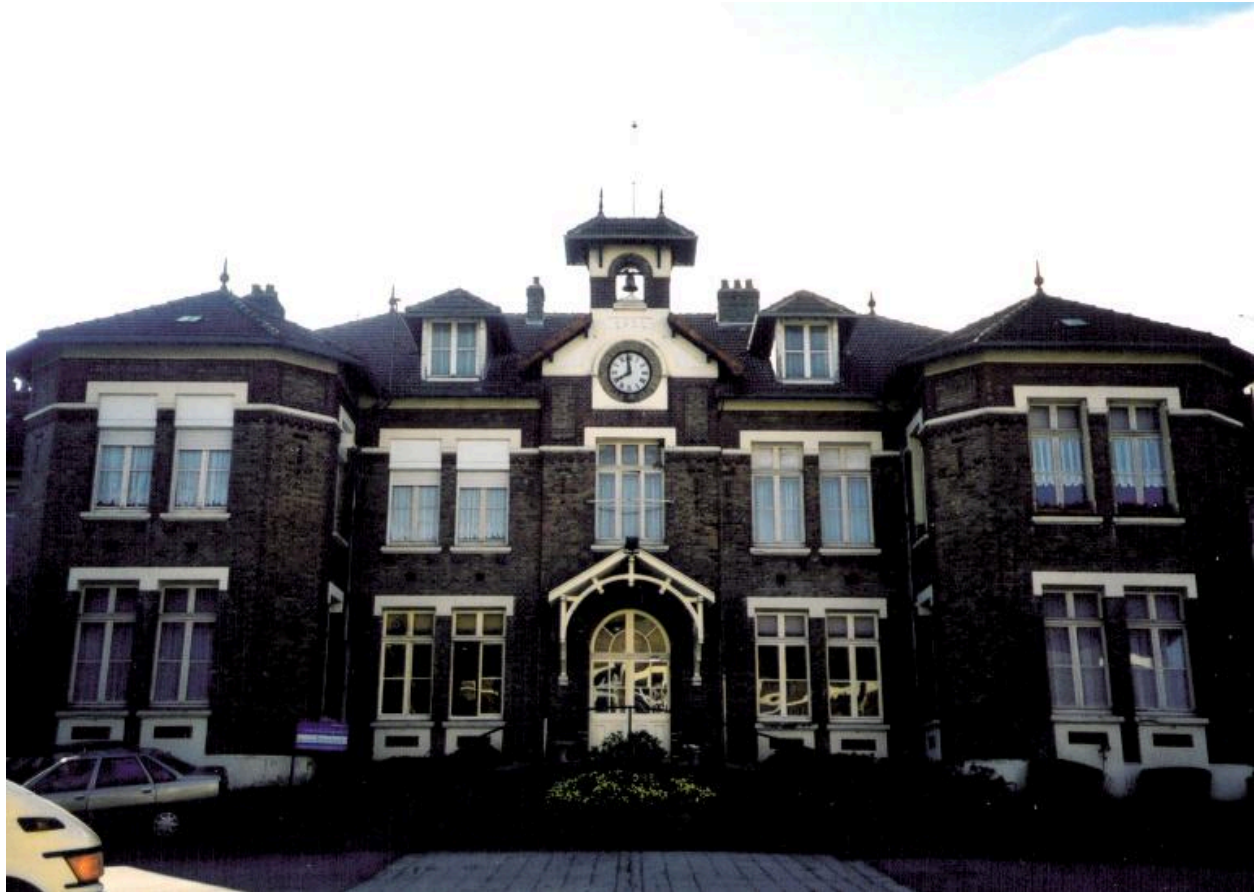
Le centre hospitalier, dans le faubourg de Chauny.
