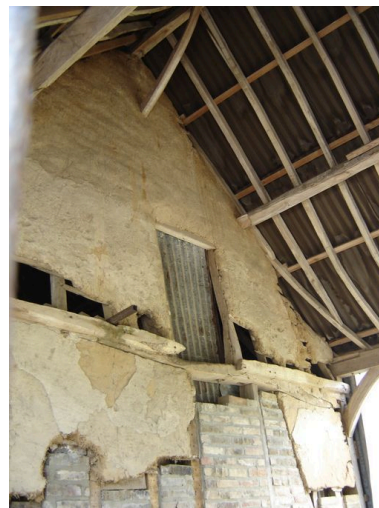
Détail du pignon de la grange. Phot. Inès Guérin IVR22_20058005824NUCA
