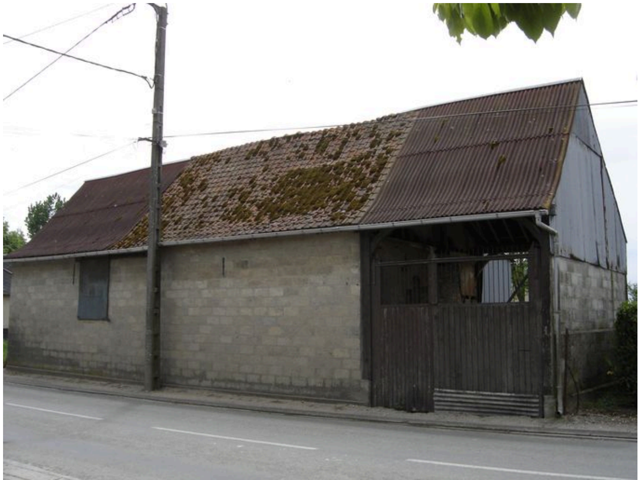
Vue générale de la grange.
