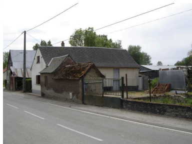
Vue générale avec logis et étables à cochons sur rue. Phot. Inès Guérin IVR22_20058005820NUCA
