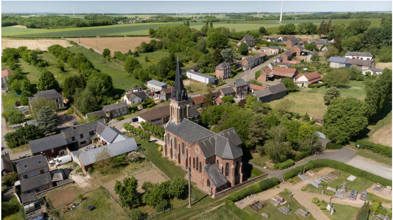
Vue aérienne de l'église depuis le sud-est.
