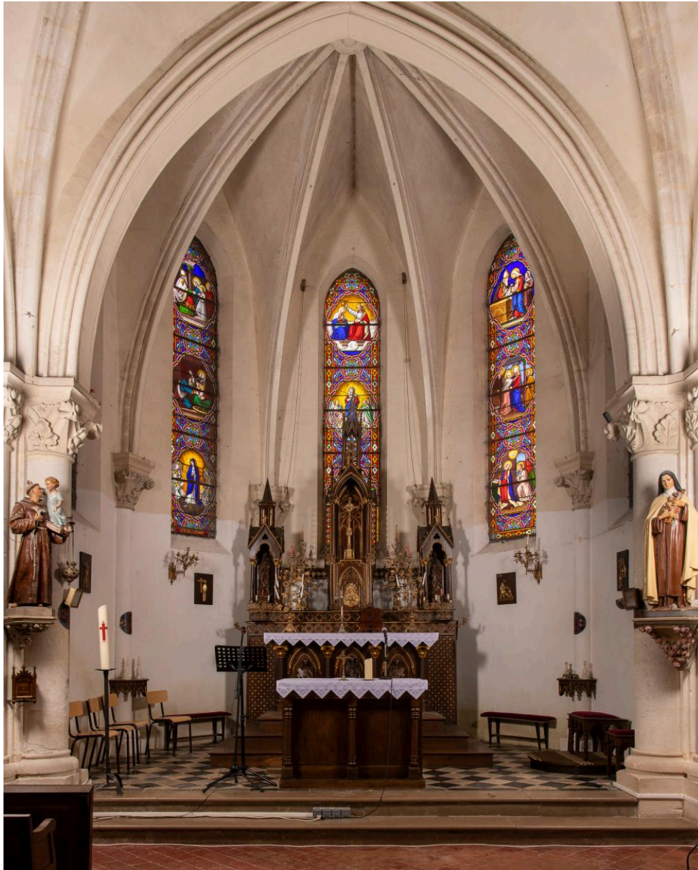
Vue générale du chœur.
