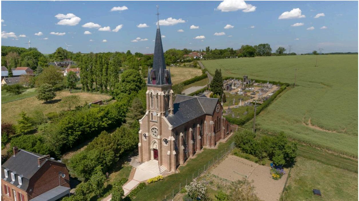
Vue aérienne de l'église depuis le sud-ouest.
