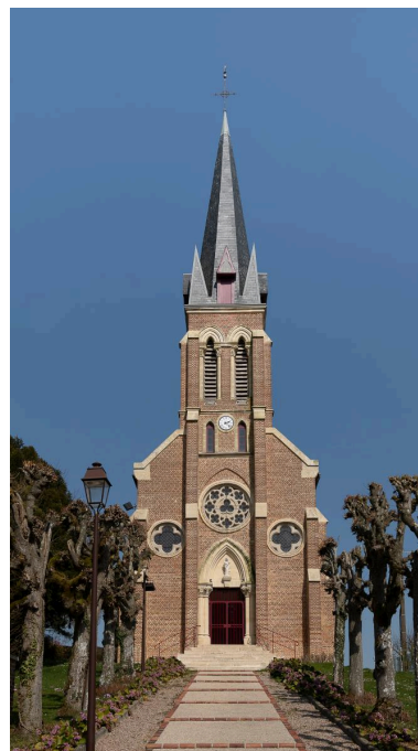
Vue générale de la façade occidentale. Phot. Marc Kérignard IVR32_20226000205NUCA
