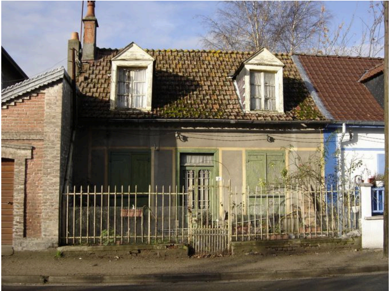
Vue du 3 rue du Général Leclerc.
