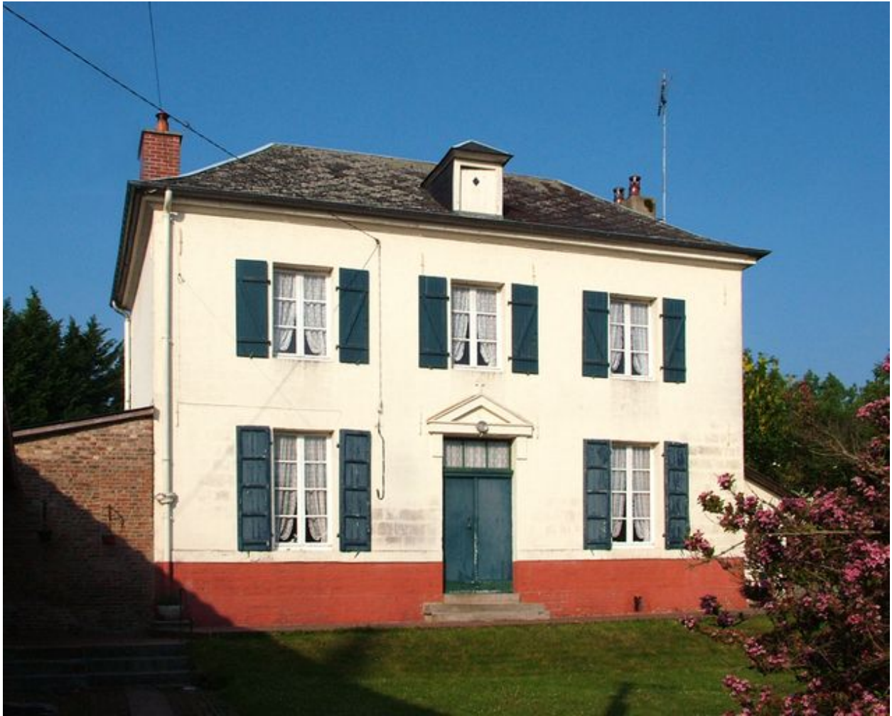
Façade sur cour.
