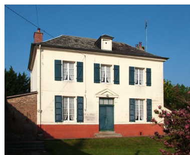
Façade sur cour.
