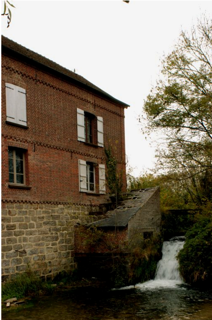
Façade nord du moulin et la chute.
