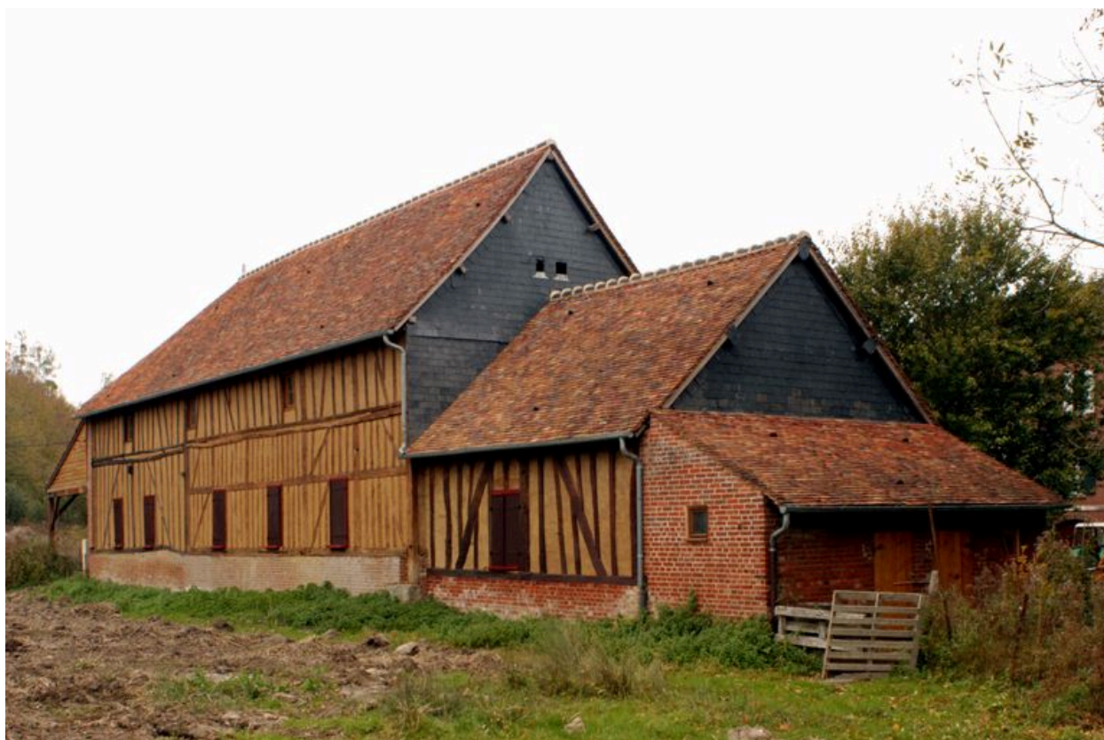
Vue d'ensemble sud-ouest de la grange.
