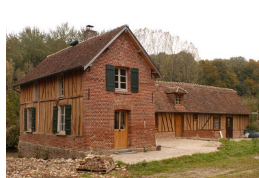
Vue d'ensemble sud des étables et des écuries. Phot. Thierry Lefébure IVR22_20036000353NUCA
