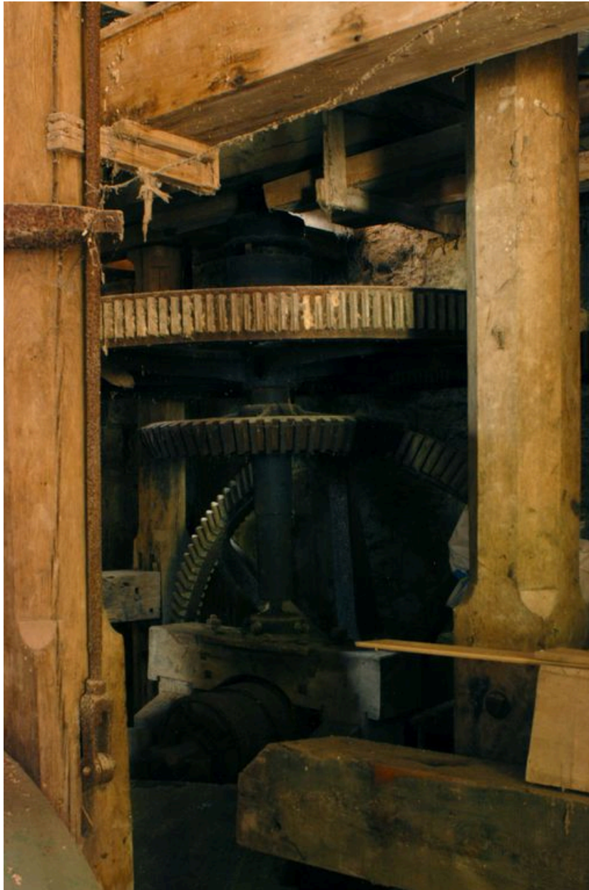
Détail du beffroi et du grand volant horizontal de transmission.
