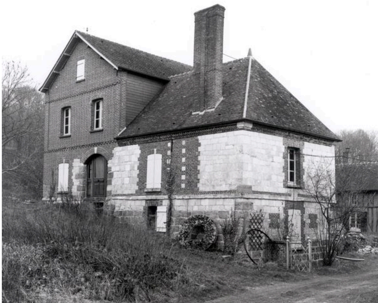
Vue d'ensemble du moulin à farine et du logement de meunier en retour.
