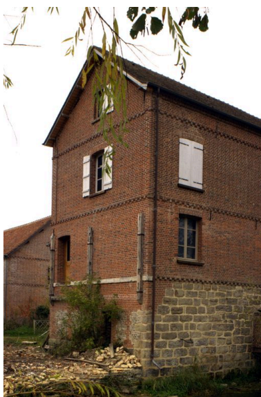
Elévation nord-est du moulin. Phot. Thierry Lefébure IVR22_20036000360NUCA
