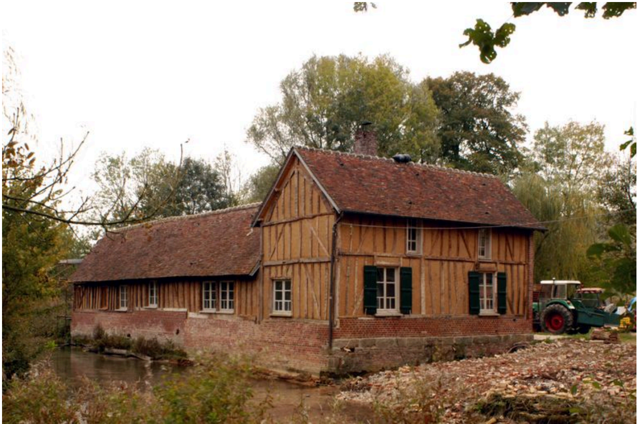
Vue d'ensemble nord des étables et écuries longeant la rivière.
