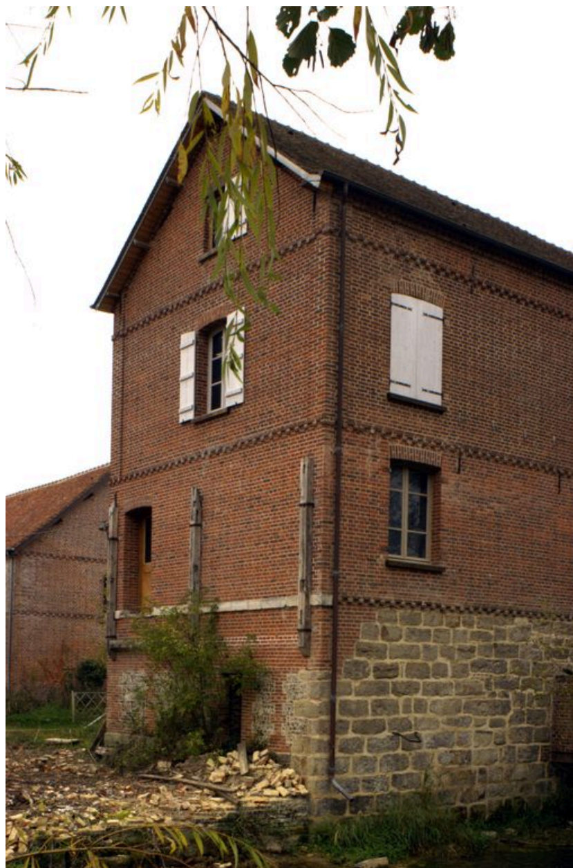
Elévation nord-est du moulin.
