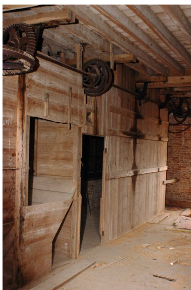
Détail de l'arbre de transmission horizontal. Phot. Thierry Lefébure IVR22_20036000365NUCA
