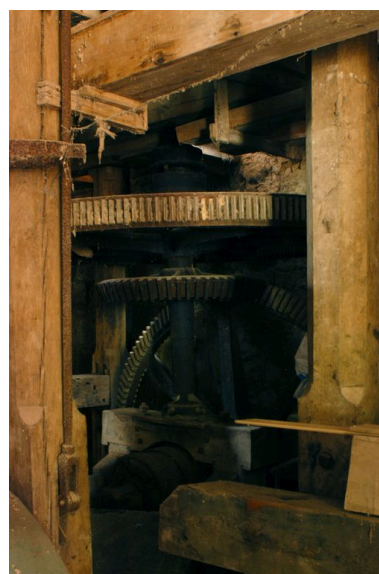
Détail du beffroi et du grand volant horizontal de transmission. Phot. Thierry Lefébure IVR22_20036000362NUCA
