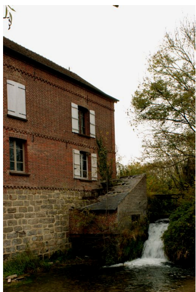
Façade nord du moulin et la chute. Phot. Thierry Lefébure IVR22_20036000359NUCA
