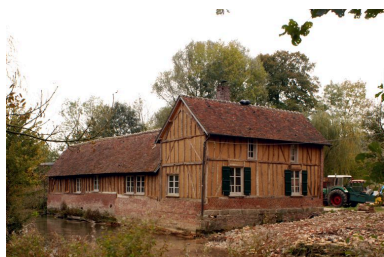
Vue d'ensemble nord des étables et écuries longeant la rivière. Phot. Thierry Lefébure IVR22_20036000358NUCA
