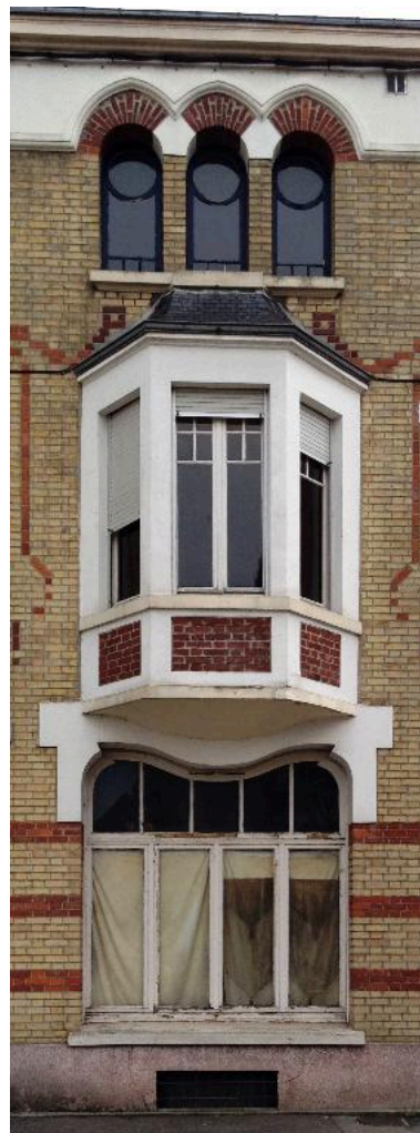
Détail d'une travée. Phot. Isabelle Barbedor IVR22_20158006112NUCA
