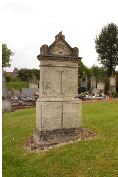
Stèle funéraire en calcaire (détruite), vers 1882. Phot. Thierry Lefébure IVR22_20038000435NUCA
