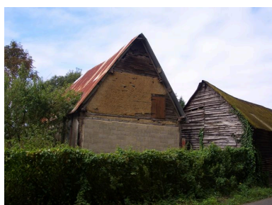
Vue du pignon en torchis et pans de bois du bâtiment en fond de cour. Phot. Inès Guérin IVR22_20078005166NUCA
