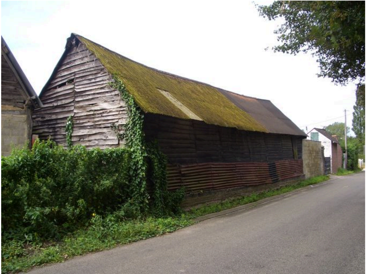
Vue de la grange longeant la rue.
