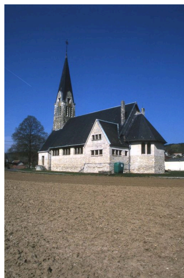
Vue depuis le sud-est. Phot. Inès Guérin IVR22_20030203177NUCA
