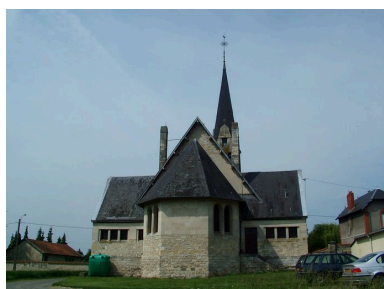
Vue du chevet. Phot. Inès Guérin IVR22_20030202569NUCA
