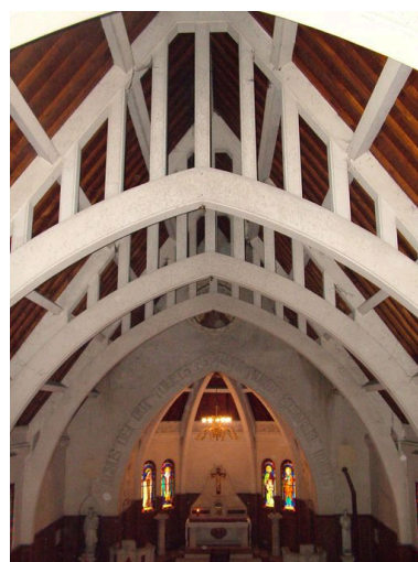
Détail de la charpente. Phot. Inès Guérin IVR22_20050200571NUCA
