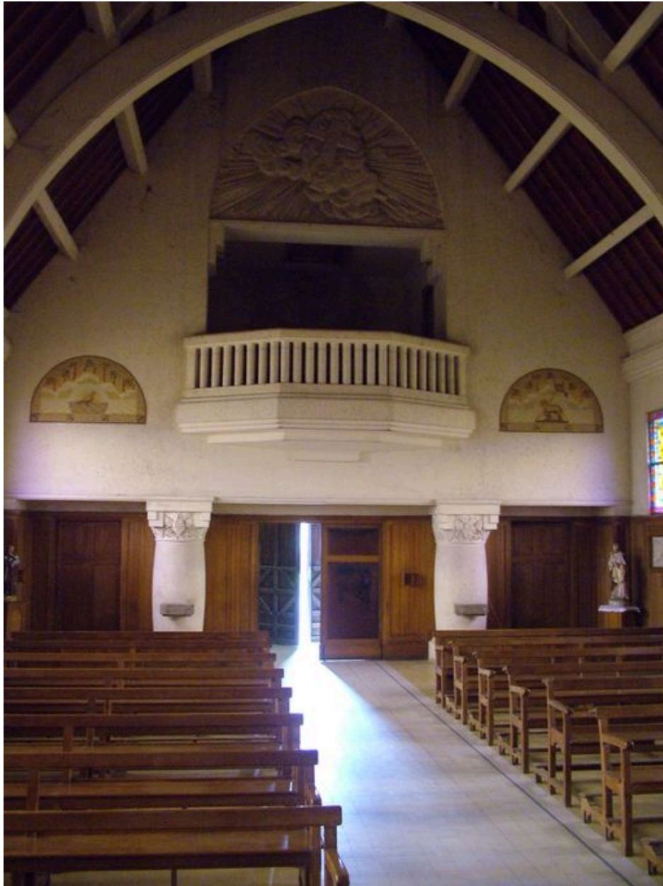
Vue intérieure du mur ouest.
