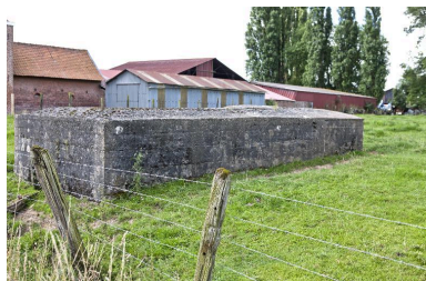
Vue vers le sud-ouest Phot. Jean-Marc Ramette IVR31_20145904599NUCA
