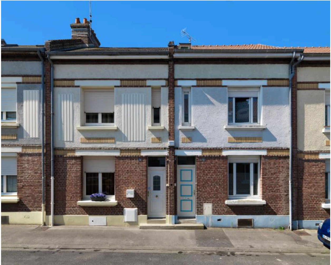
Vue de deux logements.
