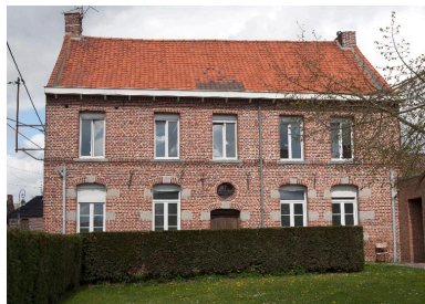
Vue générale de l'élévation postérieure. Phot. Pierre Thibaut IVR31_20125901617NUCA
