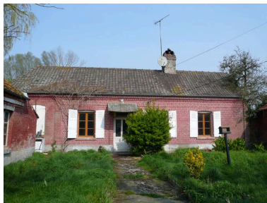
Vue du logis en fond de cour. Phot. Inès Guérin IVR22_20078005702NUCA
