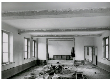
Vue générale de la crèche de l'usine d'Abbeville en cours
