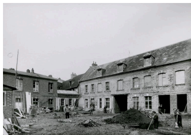
Travaux d'aménagement de la crèche à l'usine d'Abbeville, Jean-
