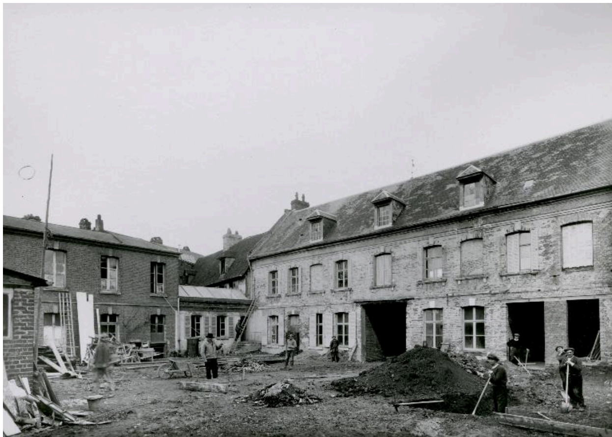
Travaux d'aménagement de la crèche à l'usine d'Abbeville, Jean-Pierre Jacquart (photographe), 1937 (AD Somme ; Série J non coté).
