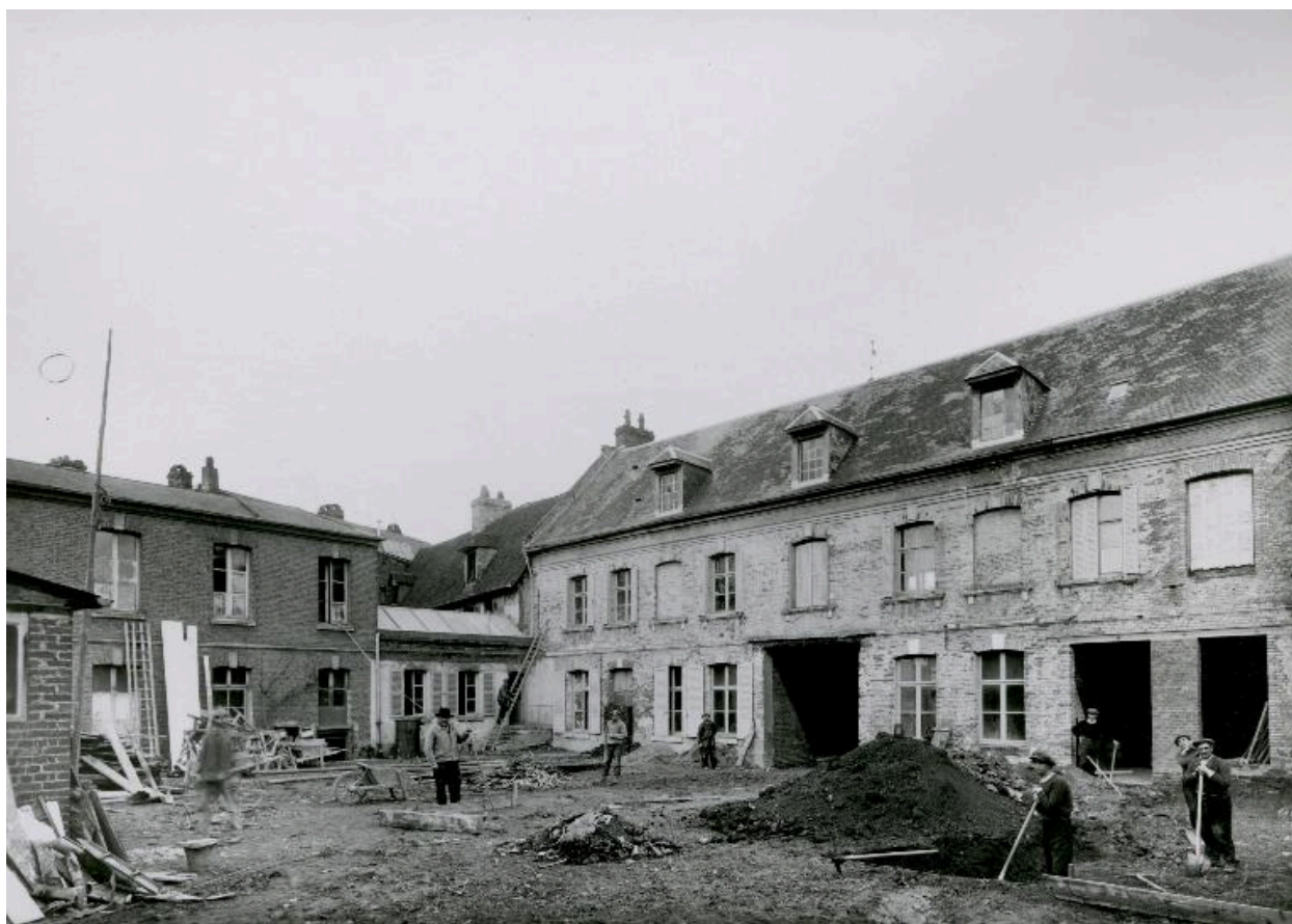
Travaux d'aménagement de la crèche à l'usine d'Abbeville, Jean-Pierre Jacquart (photographe), 1937 (AD Somme ; Série J non coté).
