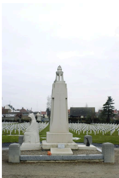
Vue latérale. Phot. Thierry Lefébure IVR22_20058000348NUCA
