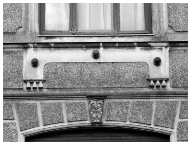
Le motif décoratif à arc déprimé et gouttes disposé dans le bandeau. Phot. Philippe Dapvril IVR31_20045900667X
