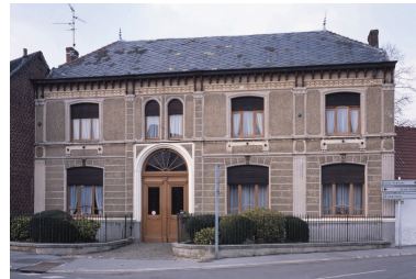
Vue générale. Phot. Pierre Thibaut IVR31_20095902007XA
