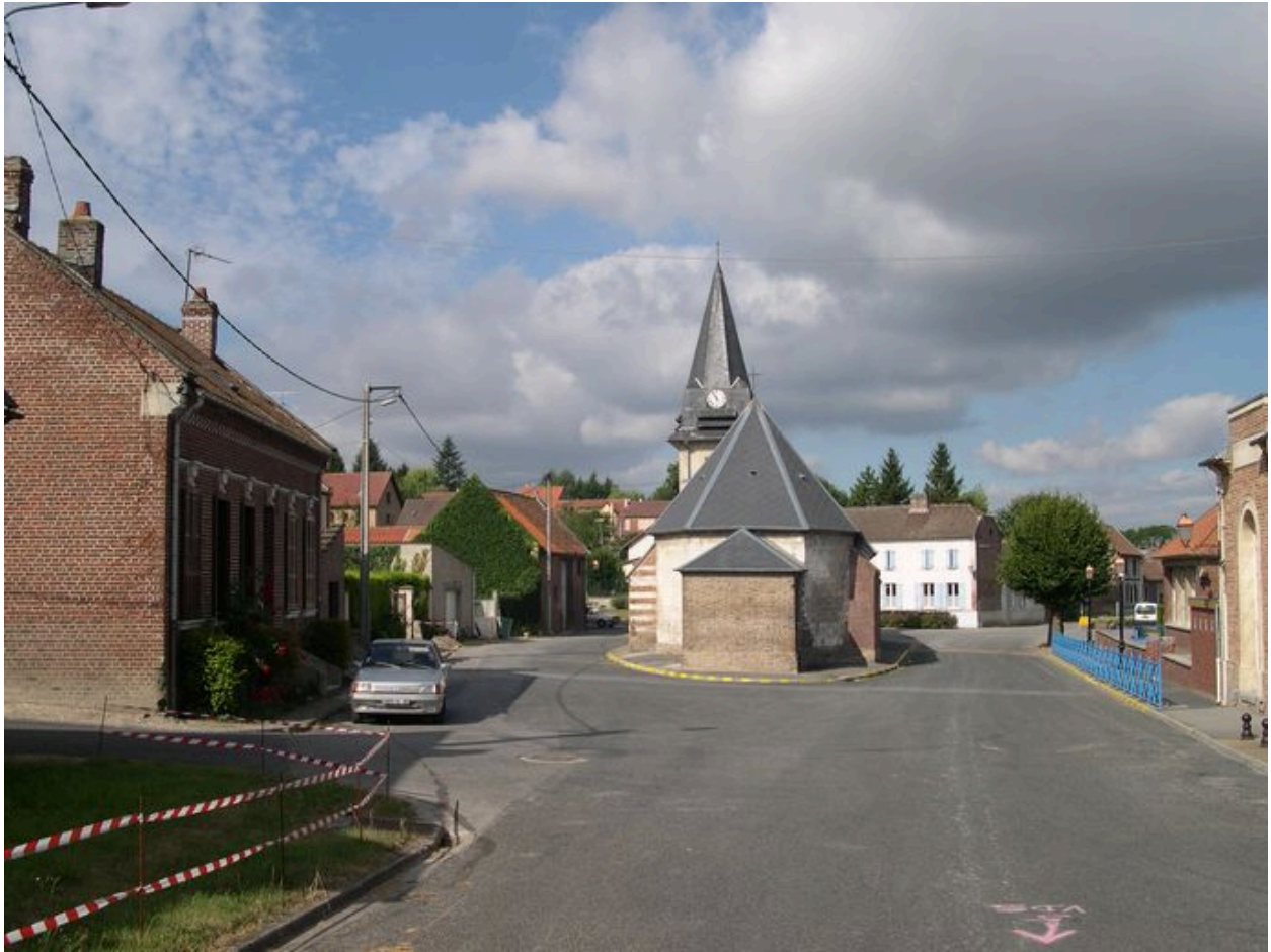
Vue générale est.
