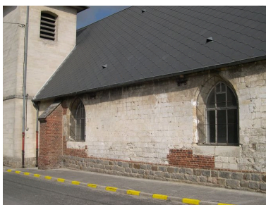
Fenêtres de la nef (mur sud). Phot. Isabelle Barbedor IVR22_20038011010NUCA
