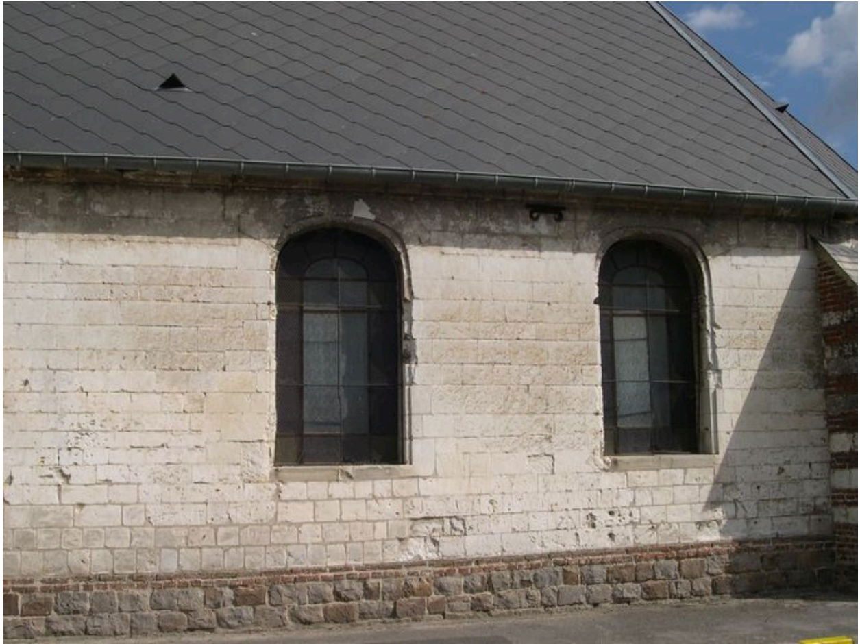
Fenêtres du choeur (mur sud).
