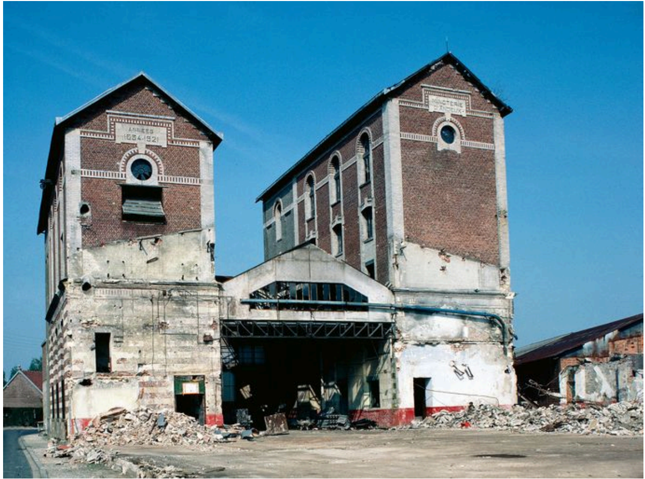
Vue en cours de destruction.
