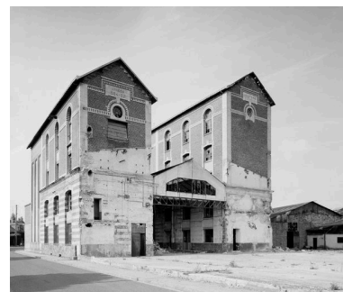
Élévation postérieure. Phot. Fabrice Charronnière IVR22_19866000135V
