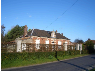
Vue générale. Phot. Inès Guérin IVR22_20068005635NUCA
