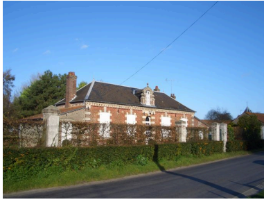
Vue générale. Phot. Inès Guérin IVR22_20068005635NUCA
