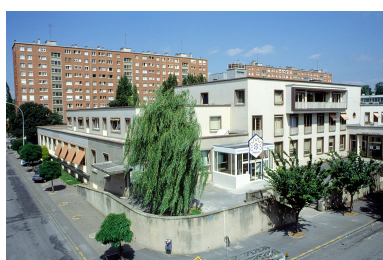
Vue de l'élévation du bâtiment de la Sécurité Sociale donnant sur la place de Wattignies. Repro. Eddy Stein IVR31_20025902156ZA
