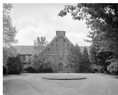
Vue de l'aile principale de l'hospice, boulevard Pasteur. Phot. Thierry Petitberghien IVR31_20025902026V
