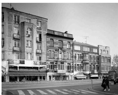
Vue générale d'un alignement de maisons construites pendant l'entre-deux-guerres, situées avenue de France (détruit). Phot. Thierry Petitberghien IVR31_20025900998V
