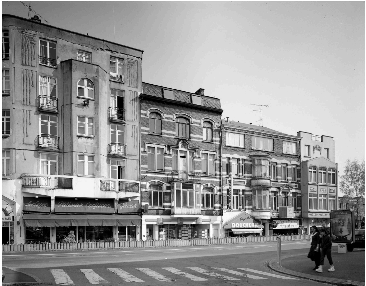
Vue générale d'un alignement de maisons construites pendant l'entre-deux-guerres, situées avenue de France (détruit).
