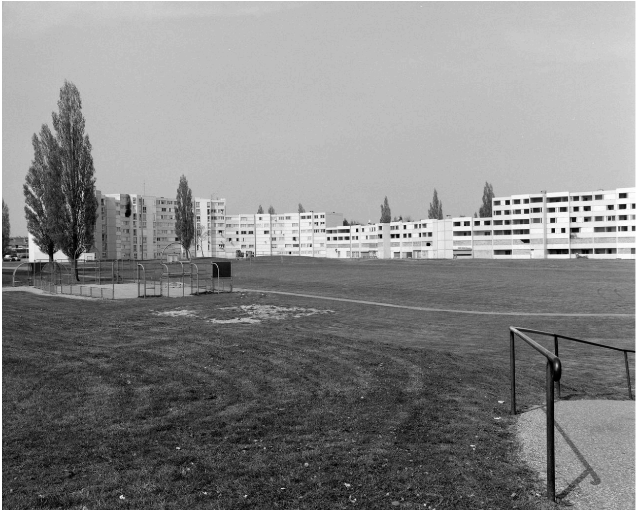
Vue de la partie sud de l'immeuble Le Vilvoorde construit dans les années 1970.
