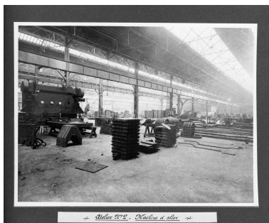
Atelier n° 2 : la machine à plier, 16 février 1940. Photographe inconnu (coll. part., archives Cerec). Repro. Thierry Petitberghien IVR31_20025900601XB
