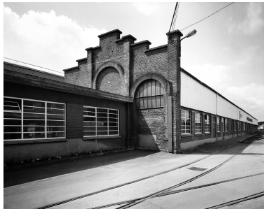
Vue générale du hall 10. Phot. Thierry Petitberghien IVR31_20025901412V
