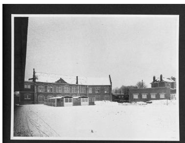
Élévation postérieure des bureaux (à gauche), les garages (à droite) et la maison patronale (arrière-plan à droite), 16 février 1940. Photographie inconnue (coll. part., archives Cerec). Repro. Thierry Petitberghien IVR31_20025900593XB
