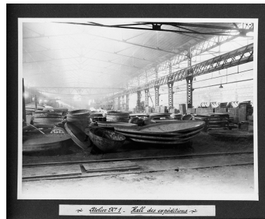
Atelier n° 1 : le hall des expéditions, 16 février 1940. Photographe inconnu (coll. part., archives Cerec). Repro. Thierry Petitberghien IVR31_20025900598XB
