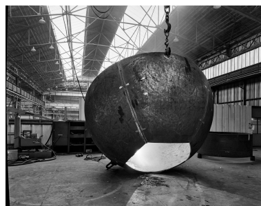
Hall 11 : le montage des segments, le soudage. Phot. Thierry Petitberghien IVR31_20025901409V
