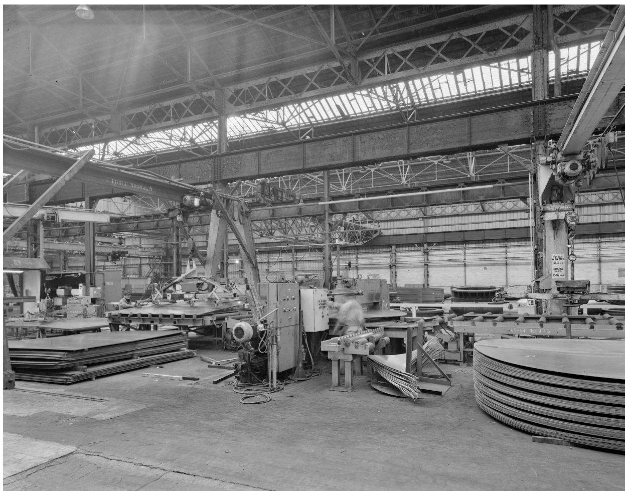
Hall 2 : le soudage et le découpage des tôles avant emboutissage.
