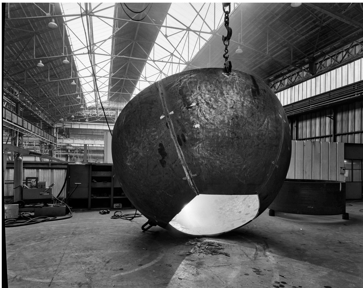
Hall 11 : le montage des segments, le soudage.
