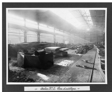
Atelier n° 2 : parc d'outillages, 16 février 1940. Photographe inconnu (coll. part., archives Cerec). Repro. Thierry Petitberghien IVR31_20025900605XB
