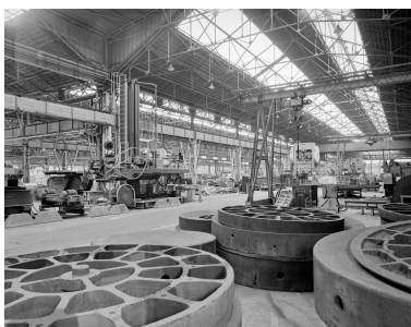
Hall 5 (?) : vue générale des presses. Phot. Thierry Petitberghien IVR31_20025901408V
