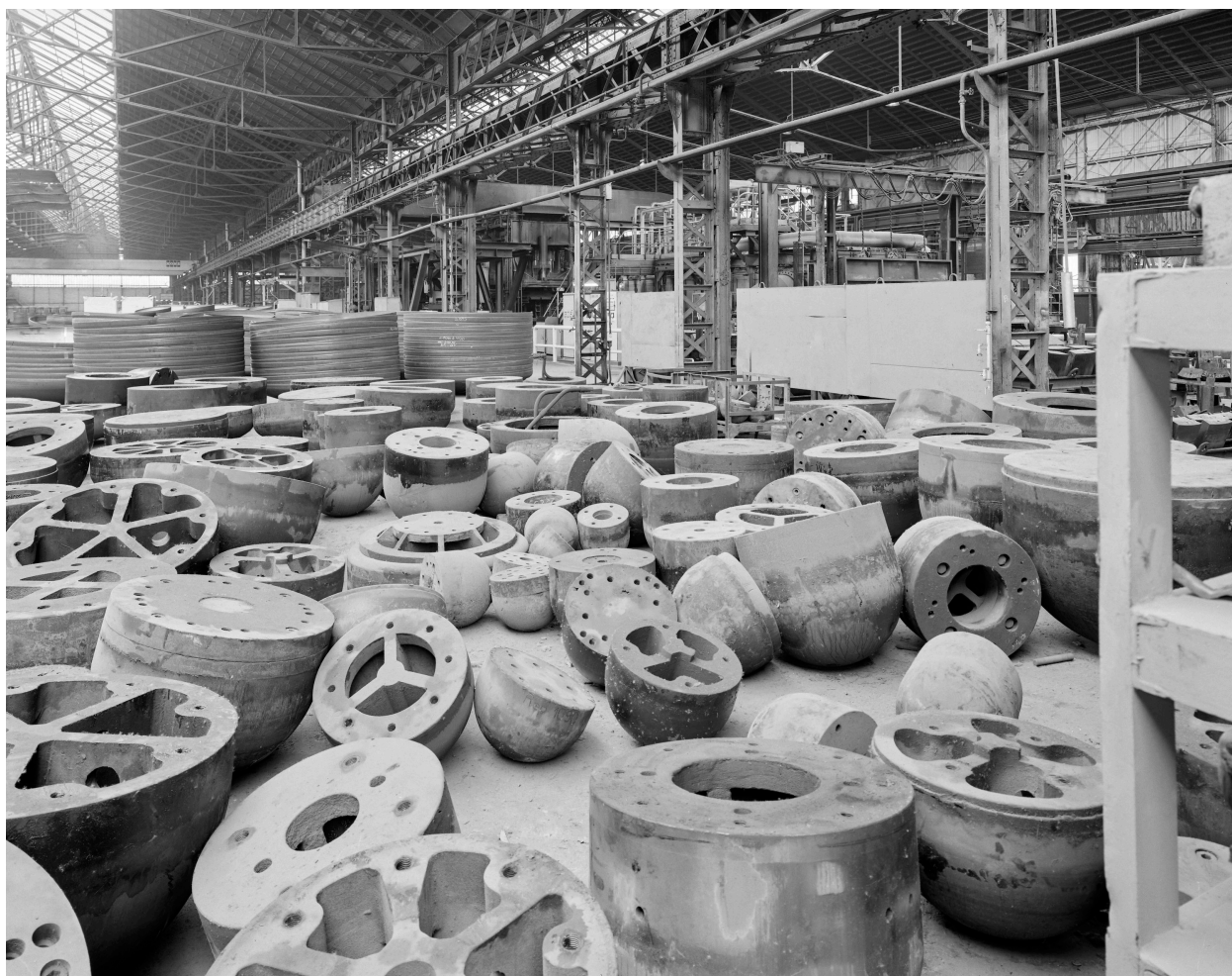
Halls 8 et 7 : les moules pour presses (premier plan) des fonds emboutis (dans le prolongement), le four (à droite, derrière les panneaux) et la presse 1 500 tonnes (dans le prolongement du four).
