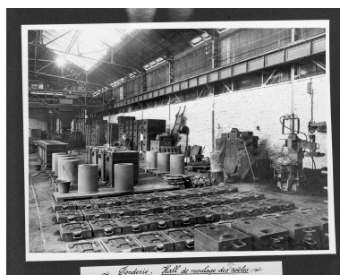
La fonderie : hall de moulage des poêles, 16 février 1940. Photographe inconnu (coll. part., archives Cerec).
