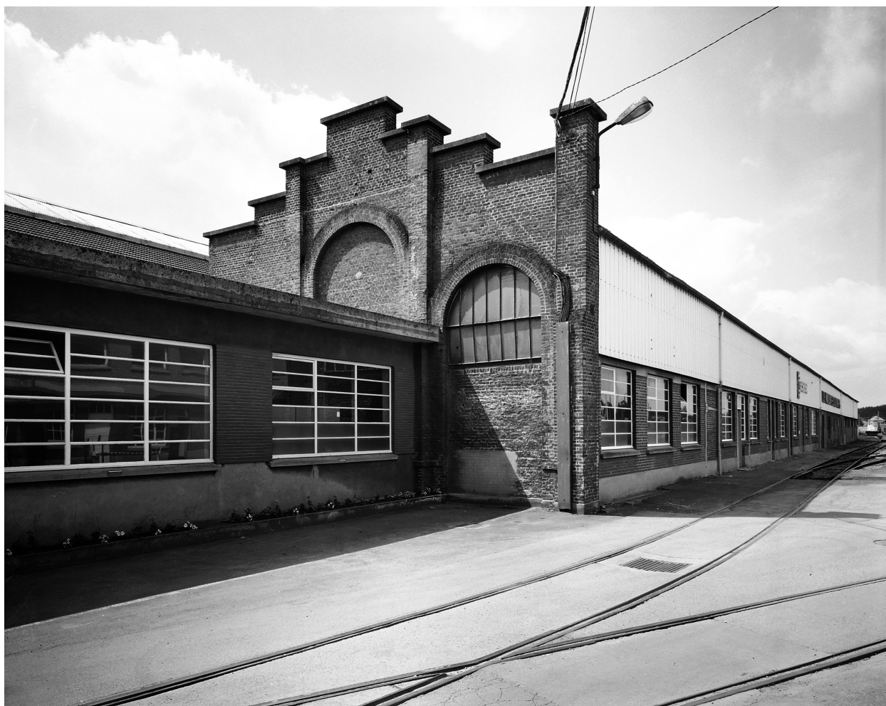
Vue générale du hall 10.
