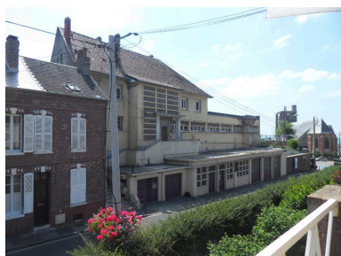
Vue générale depuis l'avenue du Général-Leclerc. Phot. Isabelle Barbedor IVR22_20158005797NUCA
