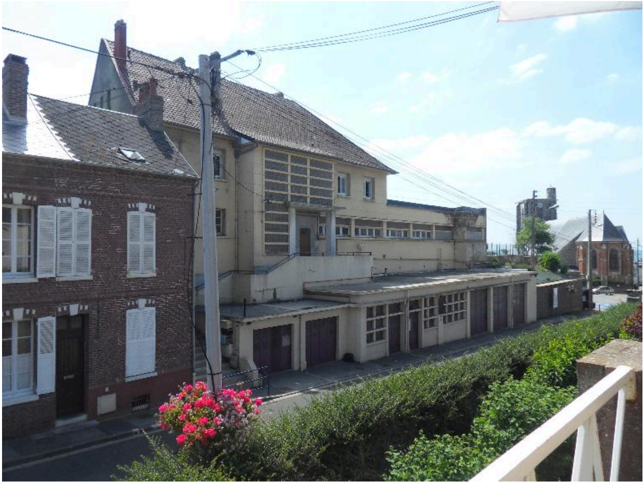
Vue générale depuis l'avenue du Général-Leclerc.
