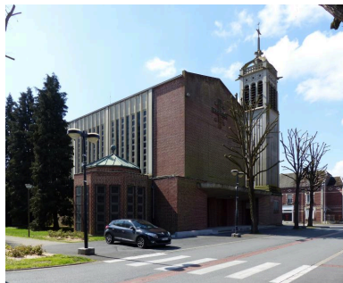
Vue partielle depuis le nord-est. Phot. Isabelle Barbedor IVR32_20210205022NUCA
