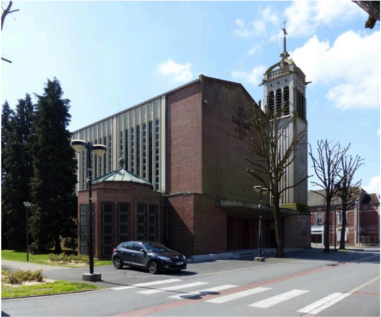
Vue partielle depuis le nord-est.
