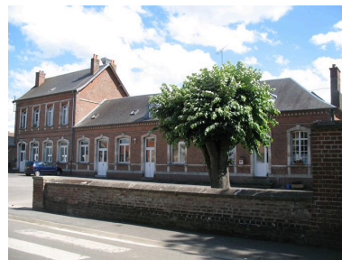
Vue générale. Phot. Bertrand Fournier IVR22_20088015488NUCA
