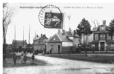
L'école de fille, à l'arrière-plan, et la maison du maire, vers 1910 (coll. part.).
