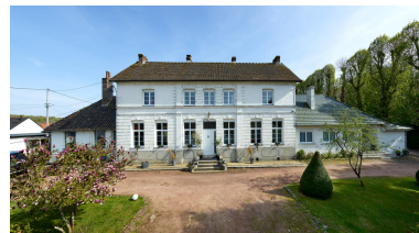
Vue générale de l'élévation nord. Phot. Thierry Lefébure IVR32_20236200420NUCA
