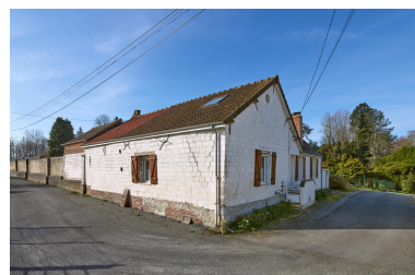
Dépendance le long de la rue de la Chapelle. Phot. Thierry Lefébure IVR32_20236200390NUCA
