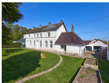
Vue de l'élévation sud depuis le sud-est. Phot. Thierry Lefébure IVR32_20236200421NUCA
