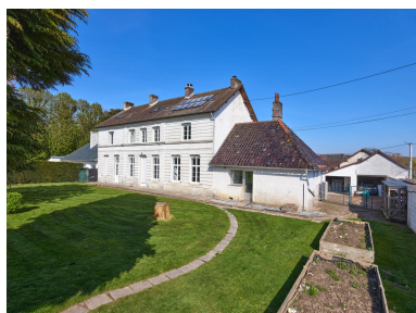
Vue de l'élévation sud depuis le sud-est. Phot. Thierry Lefébure IVR32_20236200421NUCA
