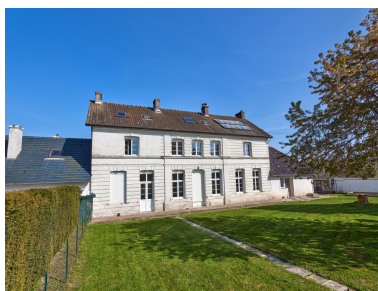
Vue de l'élévation sud depuis le sud-ouest. Phot. Thierry Lefébure IVR32_20236200422NUCA
