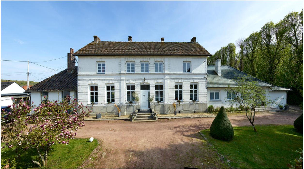
Vue générale de l'élévation nord.
