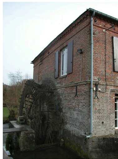
La roue hydraulique, vue de trois-quarts. Phot. Bertrand Fournier IVR22_20046002757NUCA
