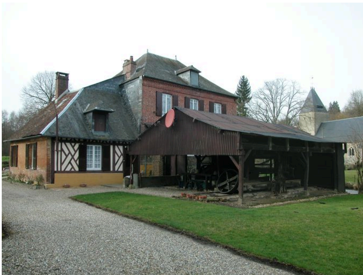
Vue d'ensemble du moulin et de l'atelier de sciage des grumes.
