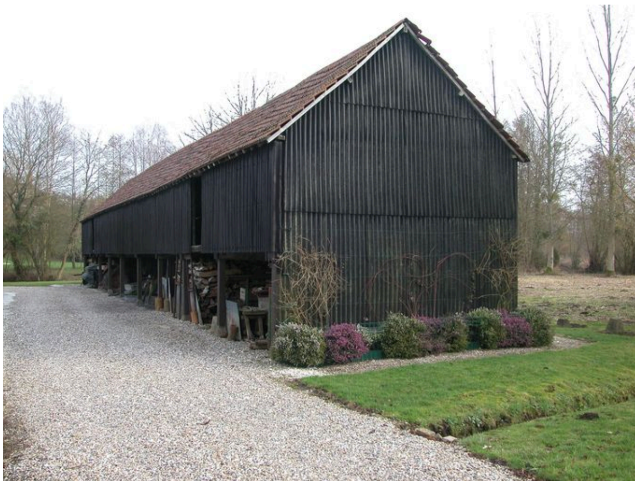
Bâtiment de stockage des bois, vue d'ensemble.
