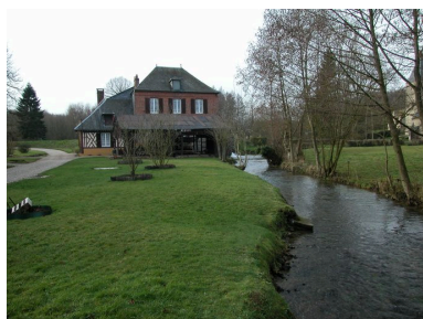
Vue d'ensemble postérieure du moulin et de la rivière en aval. Phot. Bertrand Fournier IVR22_20046002750NUCA
