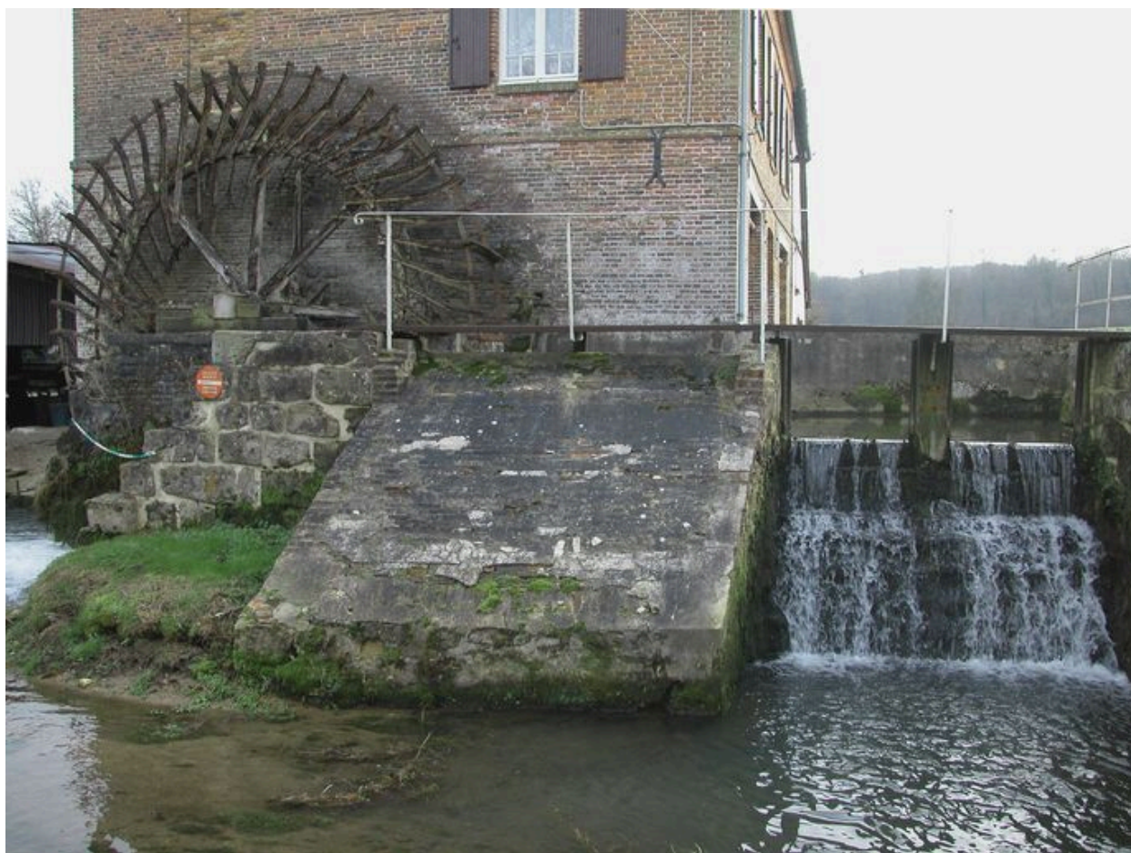
Le vannage de décharge, la chute et la roue hydraulique, vue de face.
