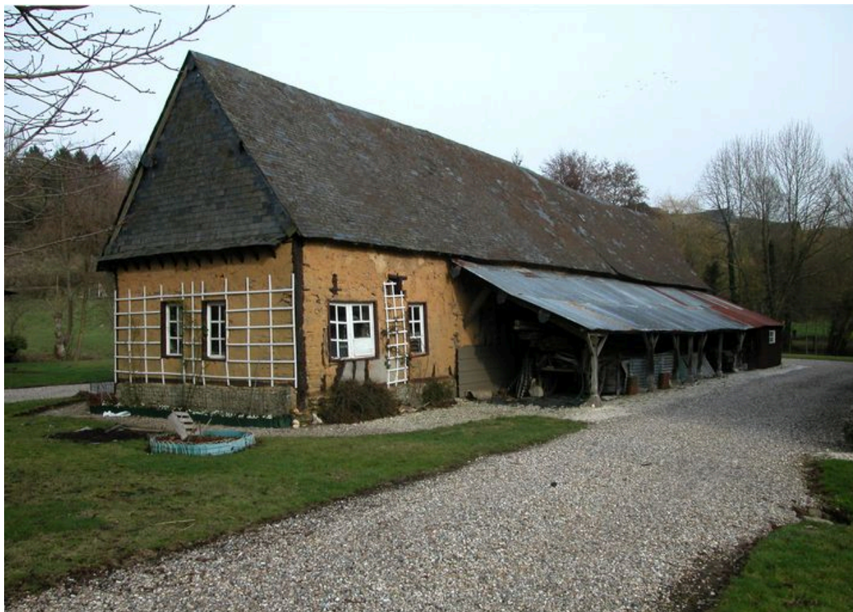
Atelier de montage des caisses, vue d'ensemble.
