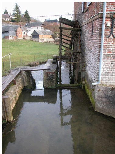
Le canal d'amenée. Phot. Bertrand Fournier IVR22_20046002756NUCA
