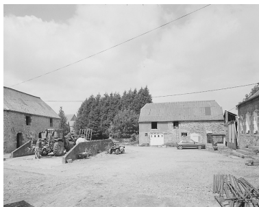
Vue des bâtiments d'exploitation. Phot. Pierre Thibaut IVR31_20055904665V
