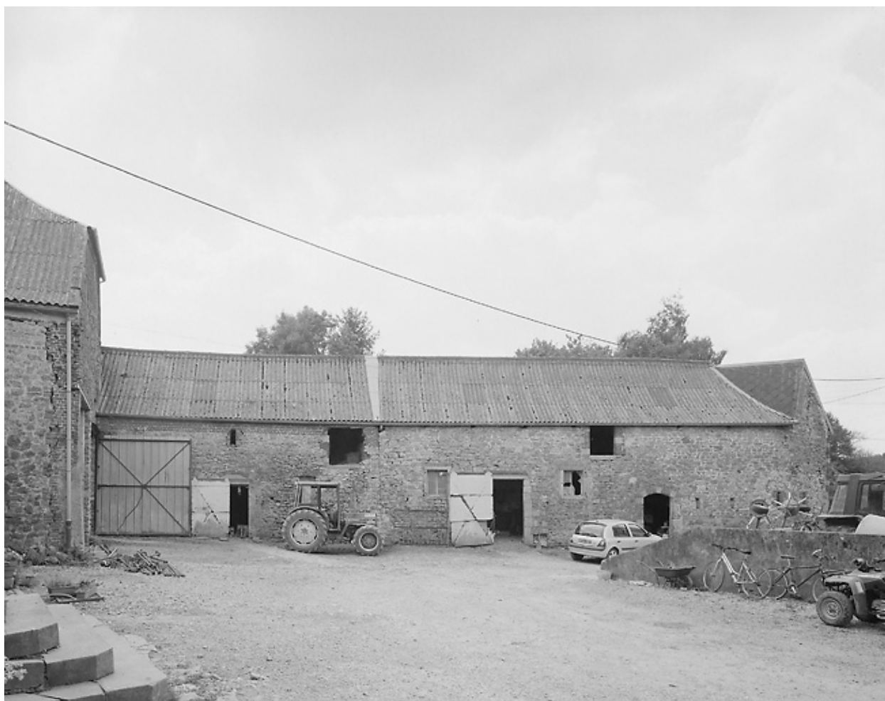
Vue des étables-fenil, contigus à la grange.
