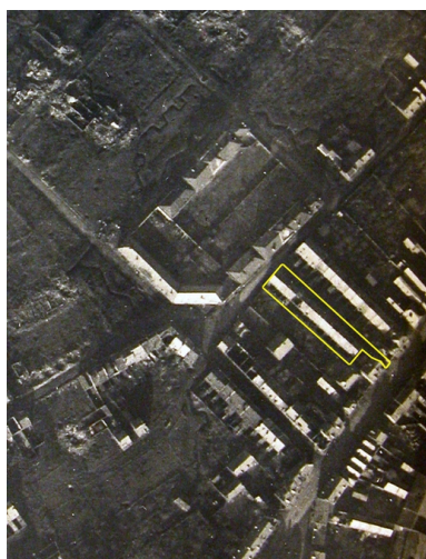
Vue aérienne du site en novembre 1918 (AD Aisne).
