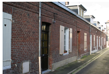
Façade antérieure de la cour Braconnier. Phot. Frédéric Pillet IVR22_20070205203NUCA
