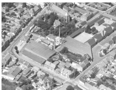
Vue aérienne, flanc sud-est. Phot. Phot'R IVR22_19888001344P
