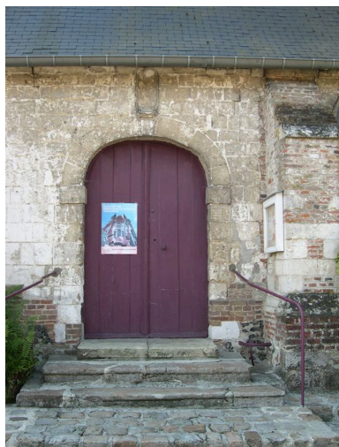
Détail sur la porte nord. Phot. Isabelle Barbedor IVR22_20038010730NUCA
