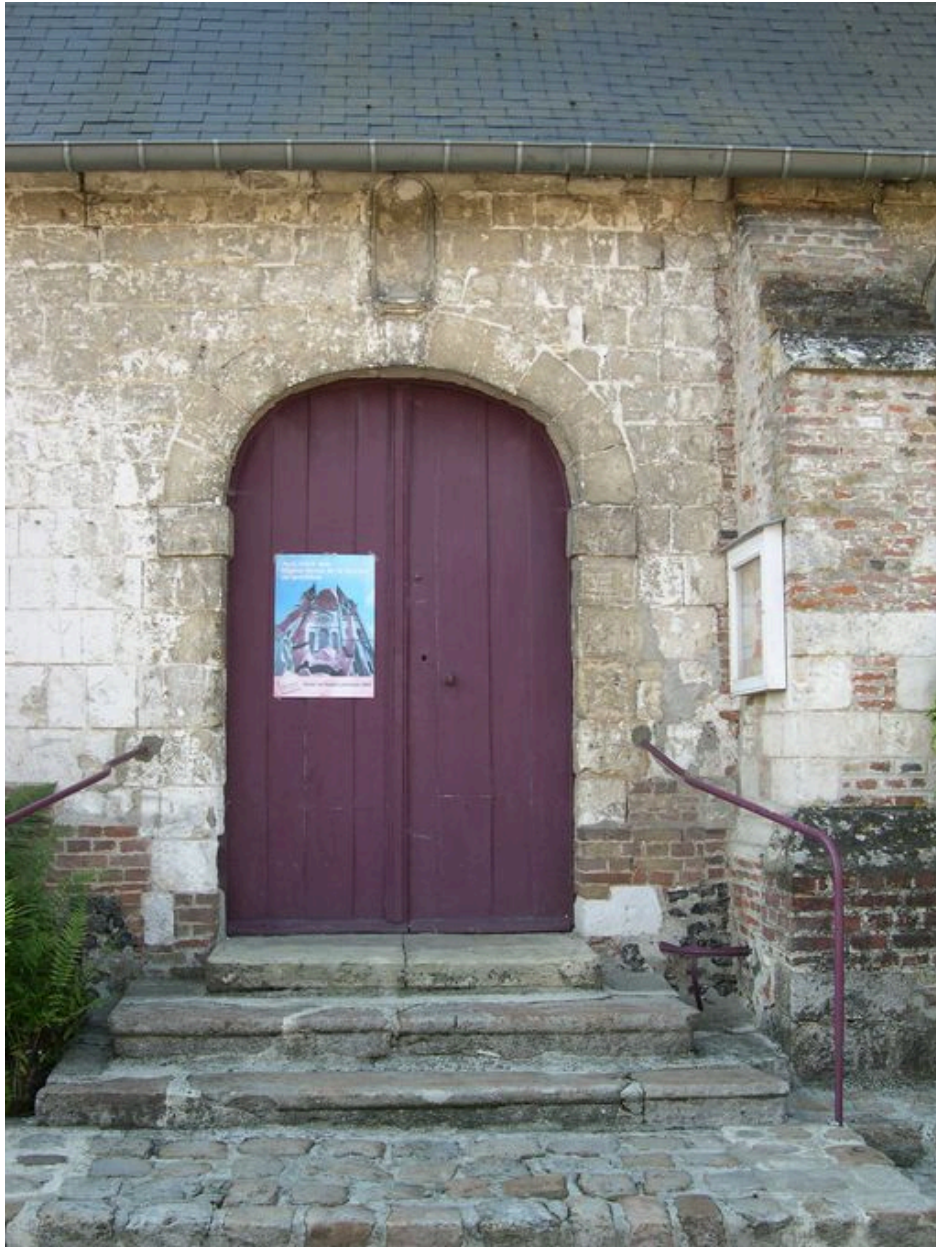
Détail sur la porte nord.
