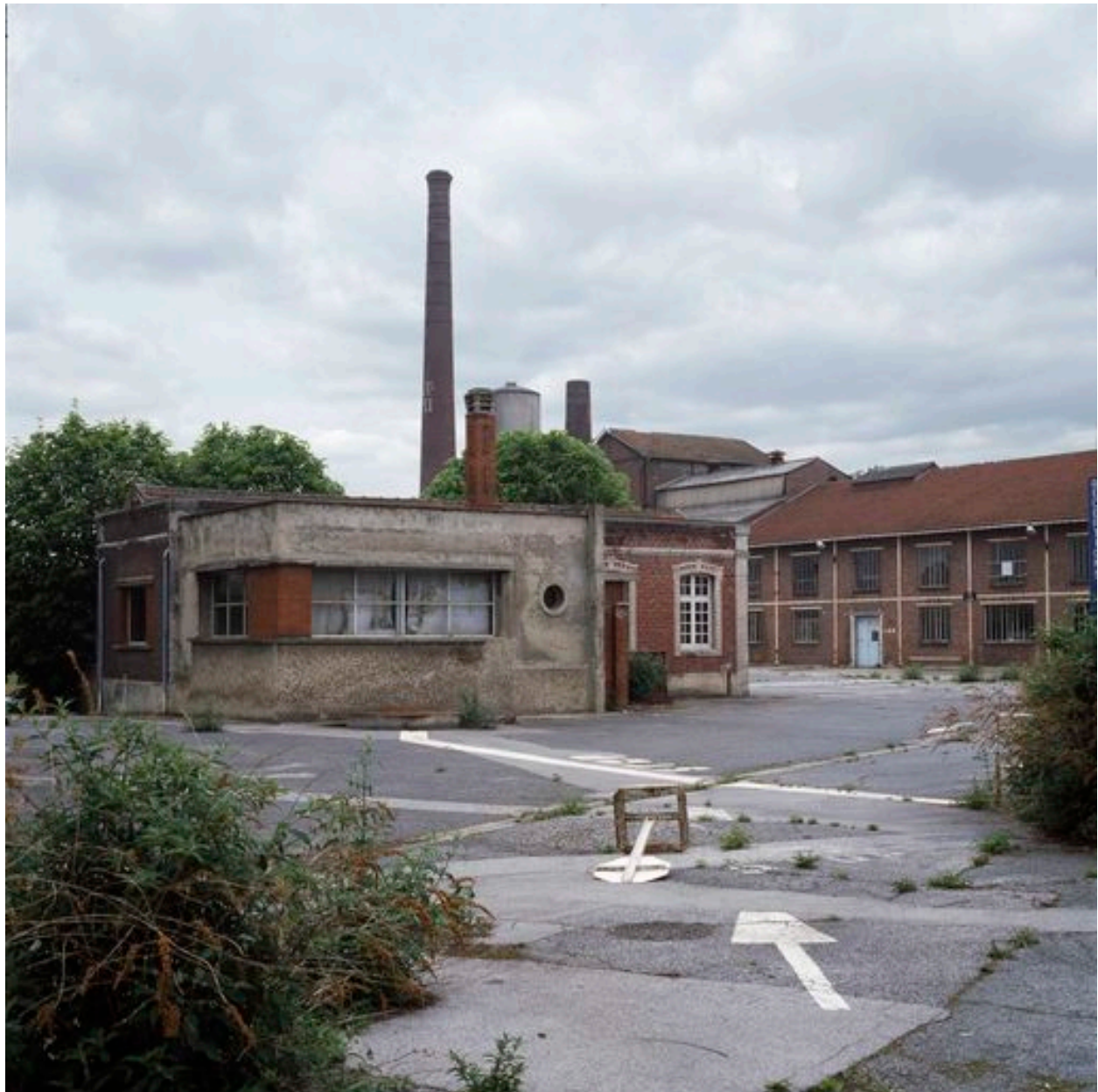
Ancienne bâtiments des douches et buanderie.
