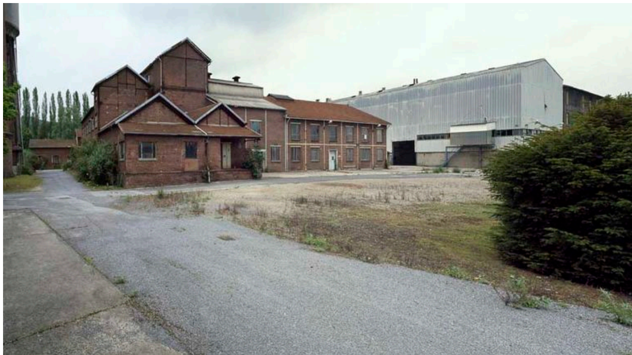
Vue panoramique des anciens ateliers de fabrication du nitrite.
