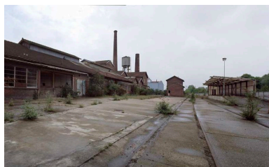
Desserte ferroviaire du site. Phot. Thierry Lefébure IVR22_20106000214XA
