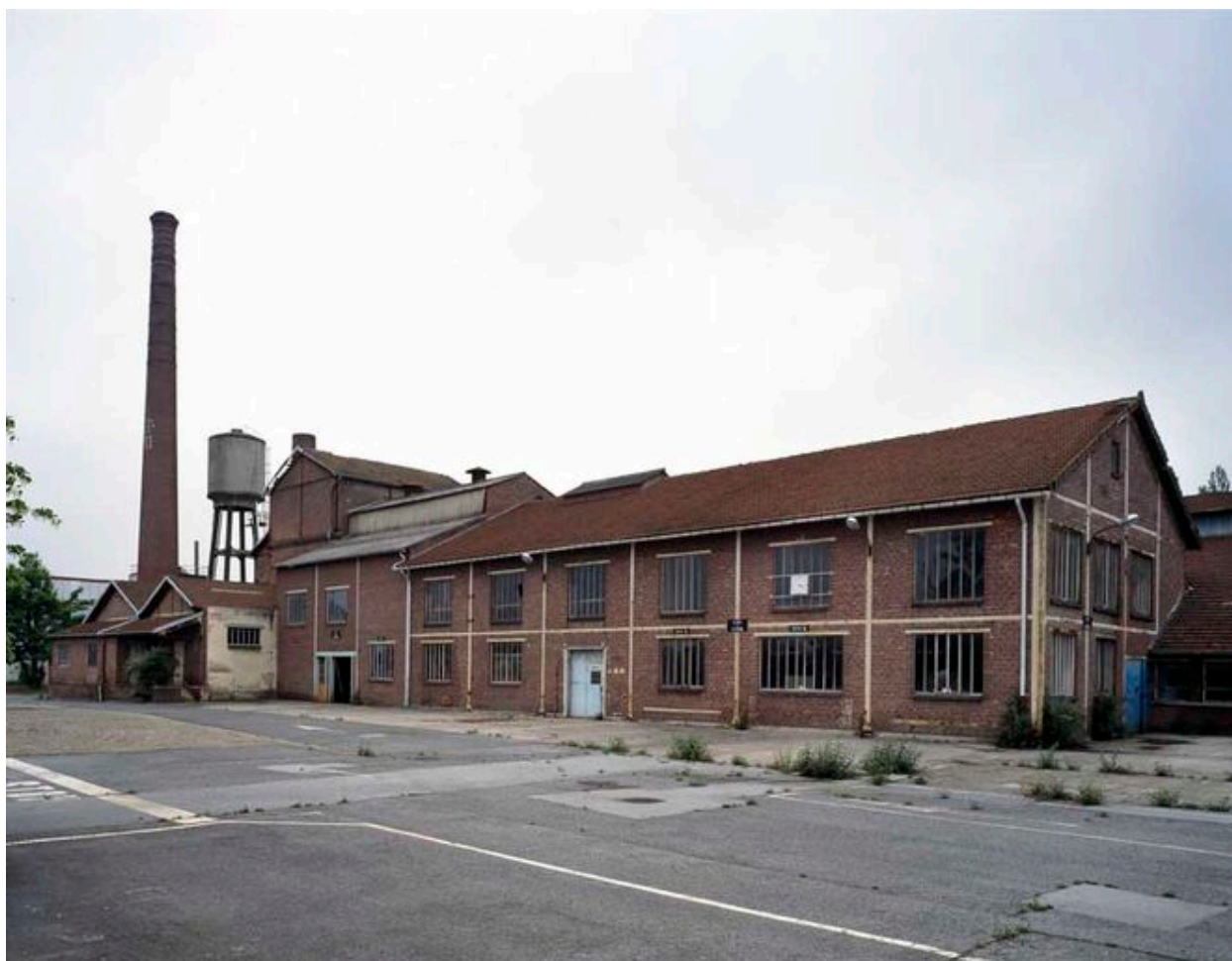
Façade des anciens ateliers de conditionnement du nitrite.
