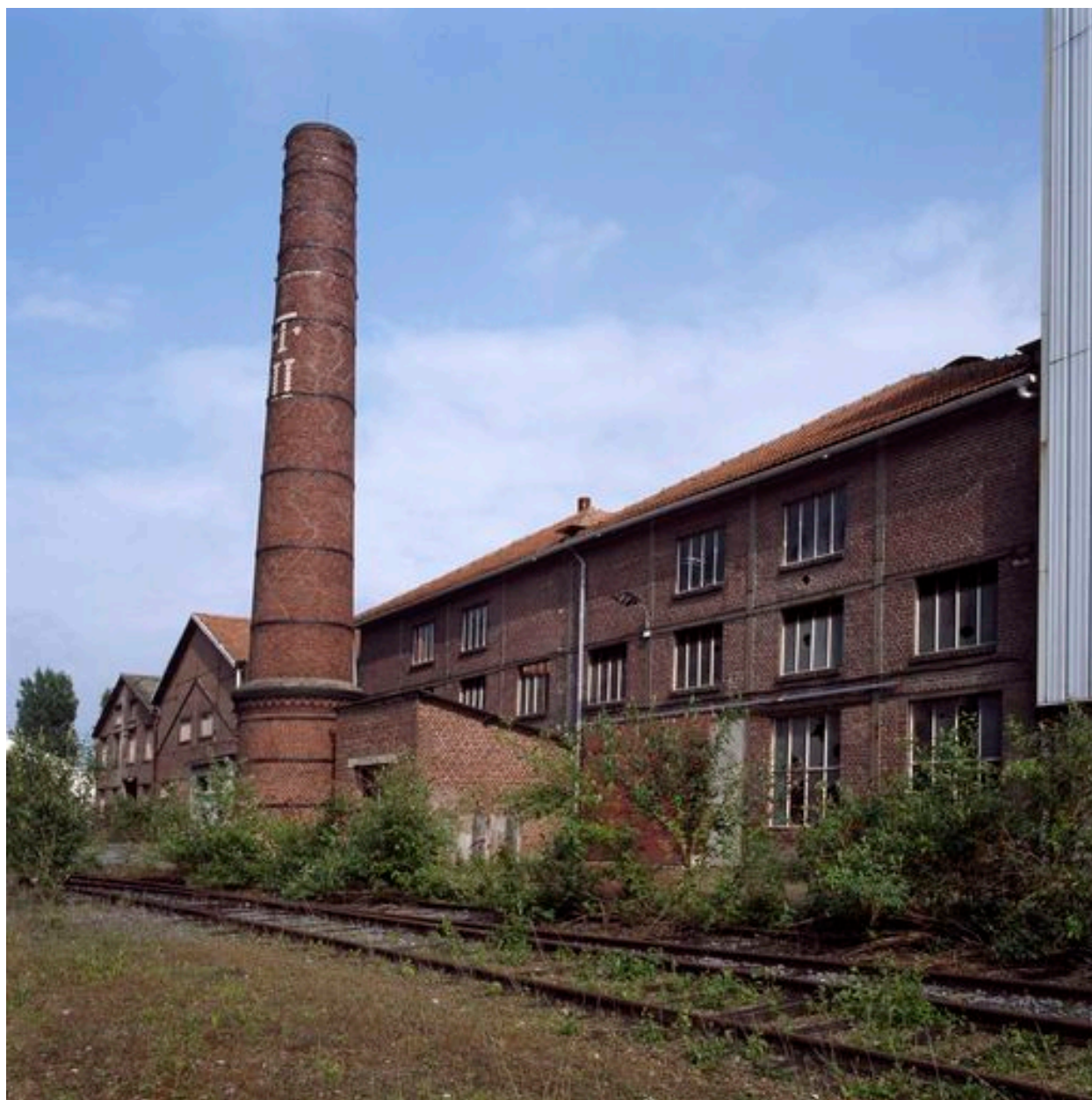
Vue des ateliers côté ferroviaire.
