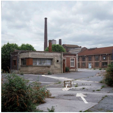
Ancien bâtiments des douches et buanderie. Phot. Thierry Lefébure IVR22_20106000199XA
