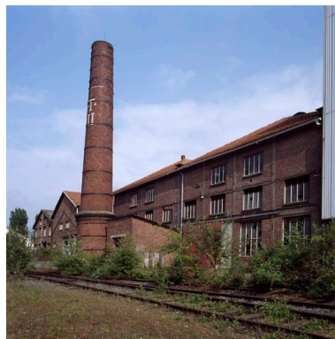
Vue des ateliers côté ferroviaire.
