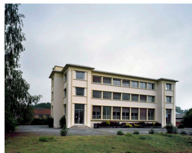
Bâtiment administratif et social (service commercial, bureau d'études, vestiaires, bains-douches, cuisines et réfectoire). Phot. Thierry Lefébure IVR22_20106000185VA
