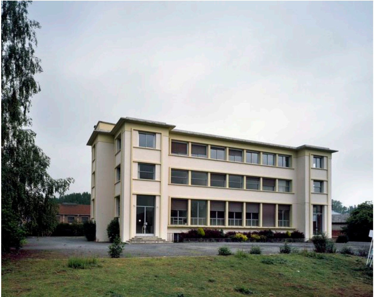
Bâtiment administratif et social (service commercial, bureau d'études, vestiaires, bains-douches, cuisines et réfectoire).
