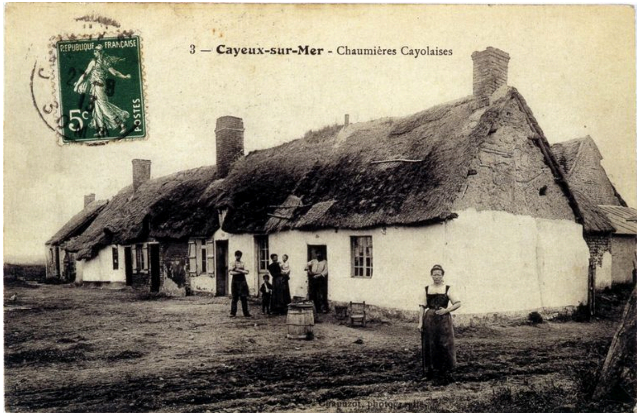
L'actuelle rue du Chauffour à Cayeux-sur-Mer (quartier de la Vieille Eglise), carte postale, 1er quart 20e siècle (coll. part.).
