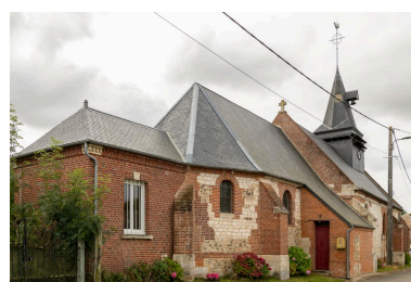
Vue depuis le nord-est (chœur et sacristies). Phot. Marc Kérignard IVR32_20216001122NUCA
