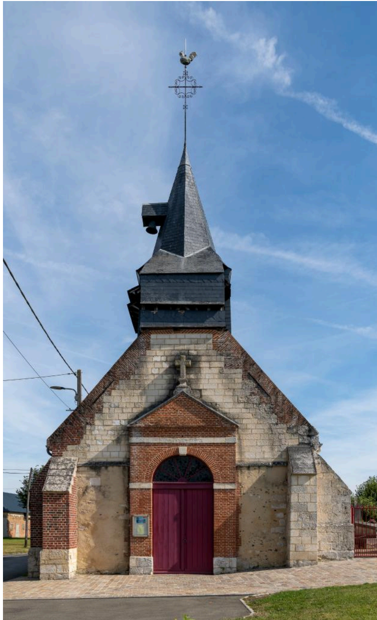
Vue générale de la façade occidentale.
