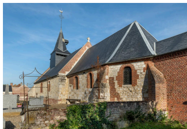
Vue générale depuis le sud-est. Phot. Marc Kérignard IVR32_20216000939NUCA
