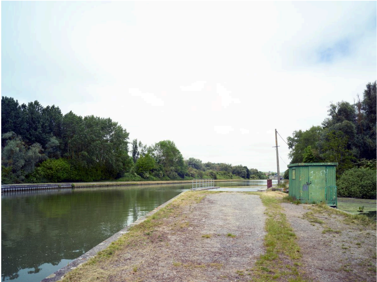
Vue depuis le sud-est. Voie de circulation. En vert, vanne de pilotage du siphon.
