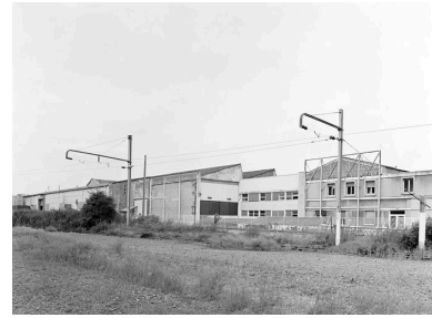
Vue générale de l'usine, flanc sud. Phot. Patrick Glotain IVR22_19936000755X
