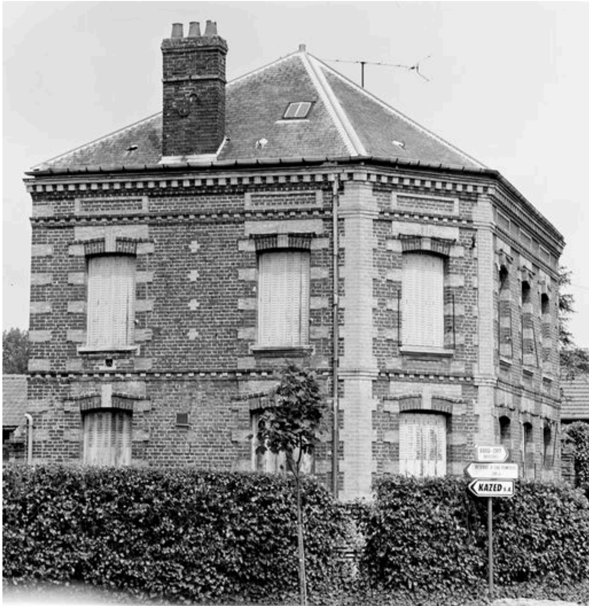
Logement patronal : élévation est.
