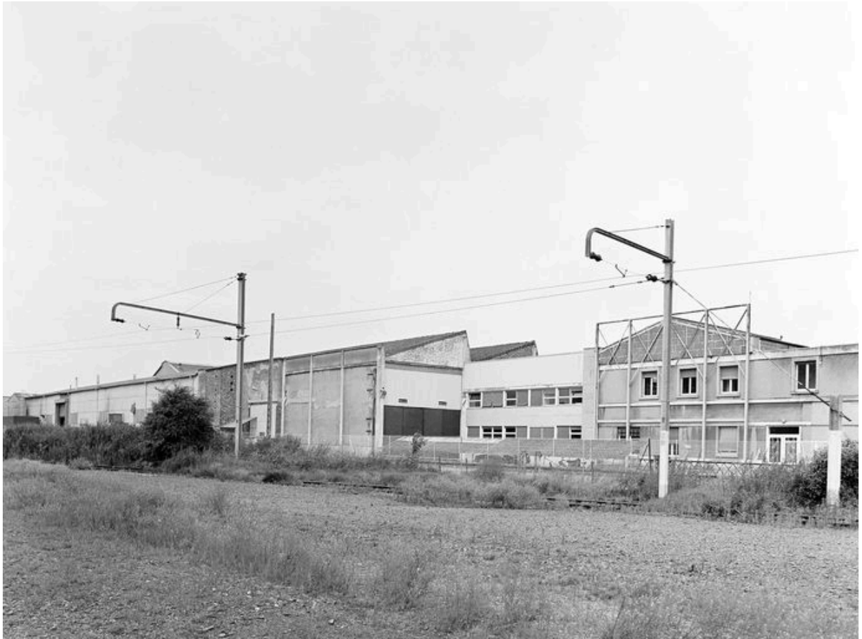
Vue générale de l'usine, flanc sud.
