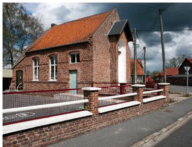
Vue générale du calvaire adossé à l'ancienne grange, aujourd'hui salle de classe. Phot. Pierre Thibaut IVR31_20125901622NUCA
