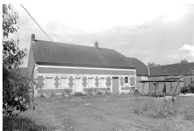
Vue depuis le sud-ouest. Phot. Xavier-Philippe Guiochon IVR22_19980201227Z
