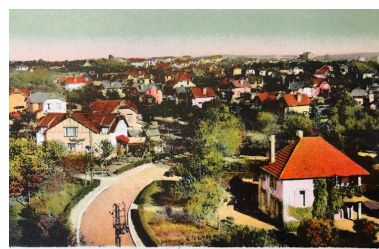
Quessy-Cité (Aisne). Vue générale. Carte postale, vers 1930 (coll. part.). Phot. Bertrand Fournier IVR32_20170205054NUCA
