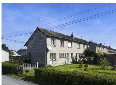
Les logements construits en 1956-1958. Phot. Thierry Lefébure IVR32_20170200149NUC2A
