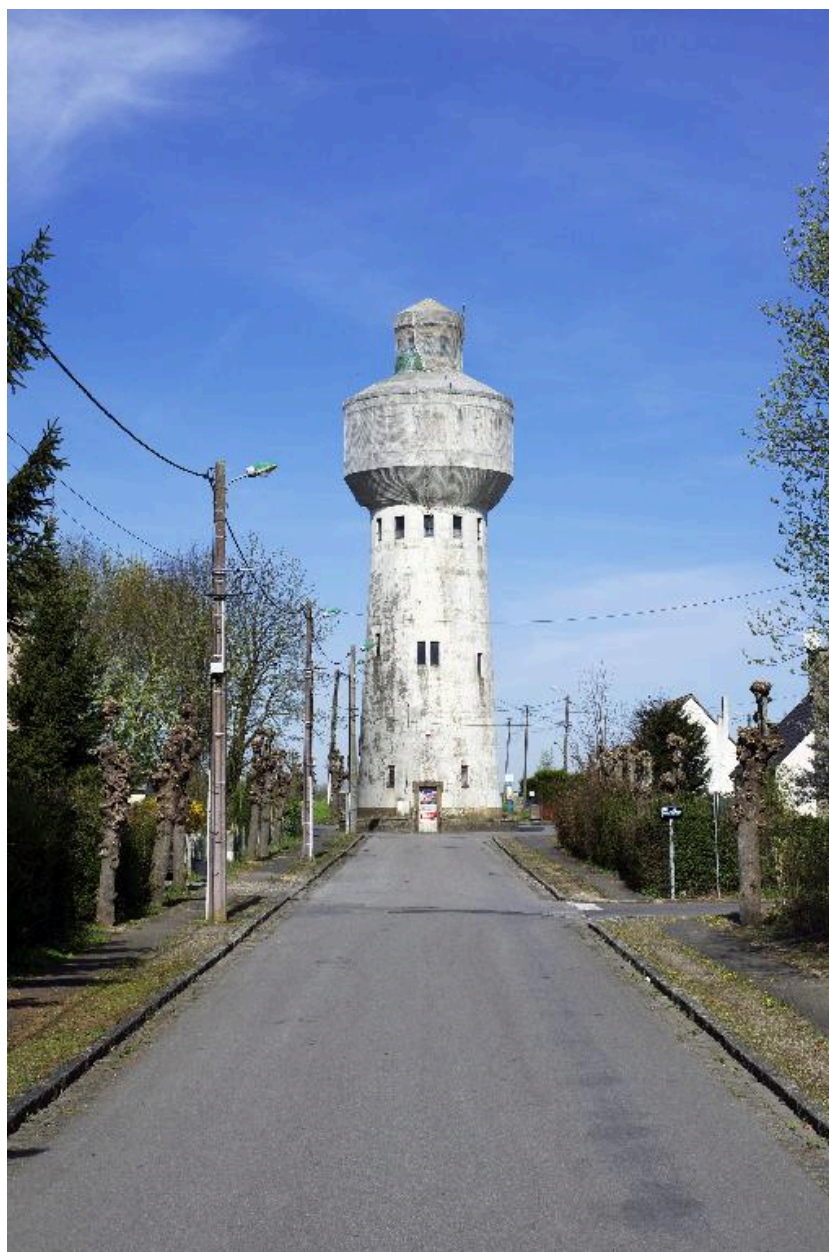
Le château d'eau belvédère, vue de situation à l'extrémité de la rue des Alliés.
