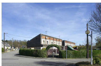
Les logements construits vers 1946-1948. Phot. Thierry Lefébure IVR32_20170200141NUC2A
