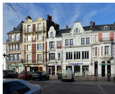
Maisons de commerce et immeuble de rapport, 18 à 24 place du Commandant-Louis-Daudré, datée 1922 (N°18) et 1925 (n°22). Phot. Isabelle Barbedor IVR32_20218005206NUCA
