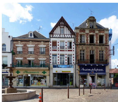
Maisons, 4 à 8 place du Commandant-Louis-Daudré. Phot. Isabelle Barbedor IVR32_20178005211NUCA
