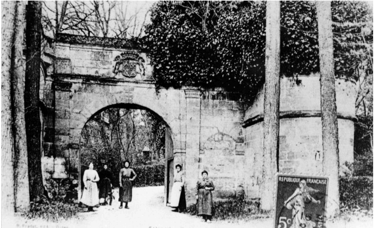
Détail de l'ouvrage d'entrée, avant 1914 (AP).
