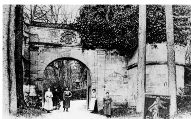
Détail de l'ouvrage d'entrée, avant 1914 (AP). Phot. Jean-Michel Périn IVR22_19856000245XB
