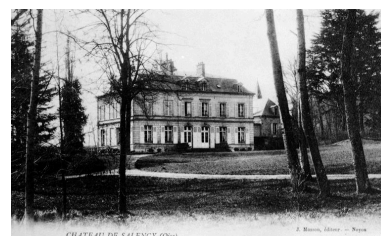
Façade principale du logis, avant 1914 (AP). Phot. Jean-Michel Périn IVR22_19856000243XB
