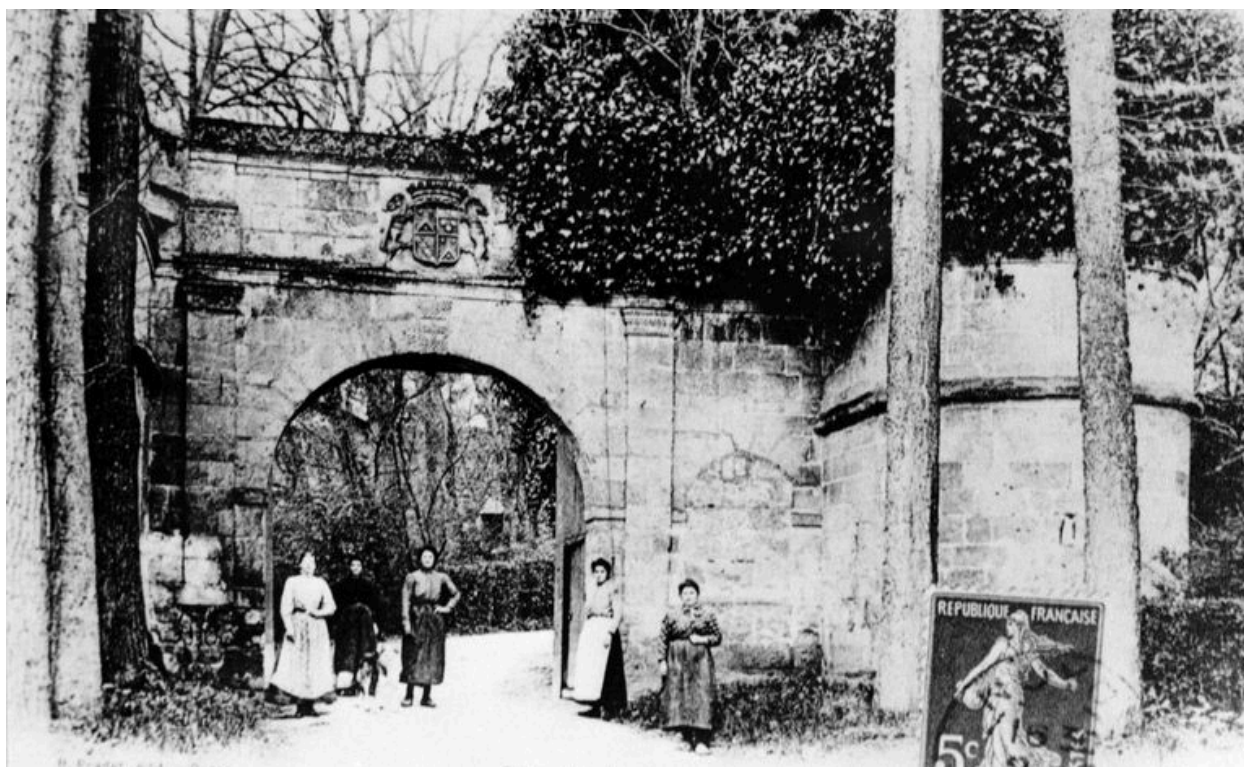
Détail de l'ouvrage d'entrée, avant 1914 (AP).
