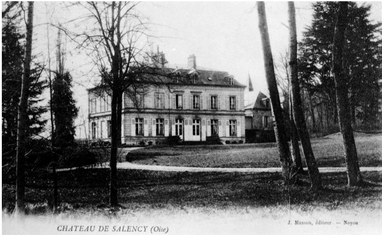
Façade principale du logis, avant 1914 (AP).
