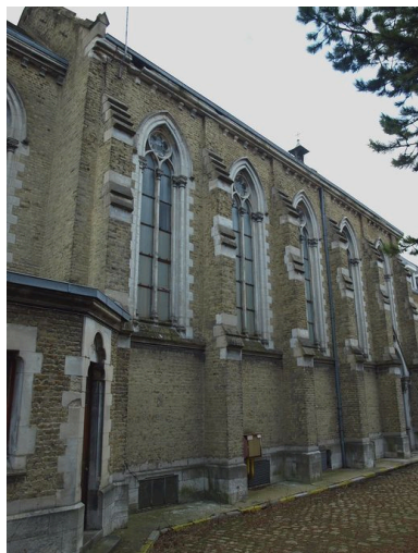
Chapelle : murs latéraux Phot. Bruno Decrock IVR31_20106202972NUCA
