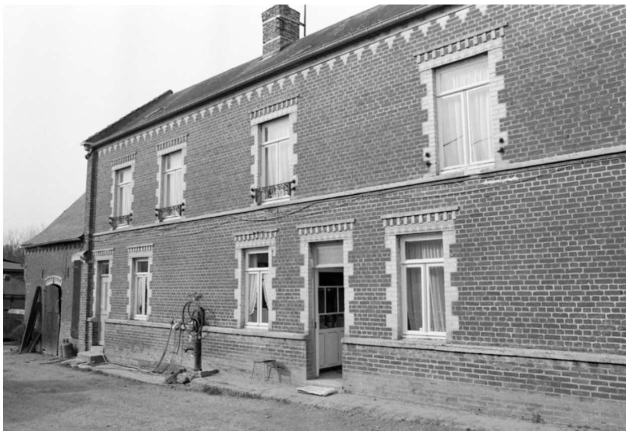
Logis : façade antérieure sur cour.
