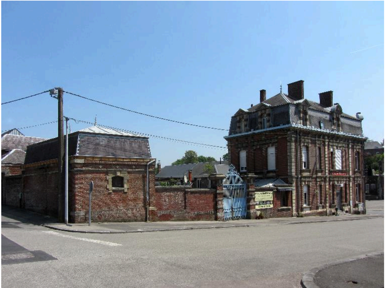
Vue d'ensemble de l'hôtel avec sa cour donnant sur la rue de l'Eglise.
