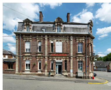
Façade de la rue de l'Eglise. Phot. Thierry Lefébure IVR22_20138000235NUC2A
