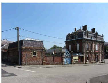
Vue d'ensemble de l'hôtel avec sa cour donnant sur la rue de l'Eglise. Phot. Bertrand Fournier IVR22_20138015837NUC2A
