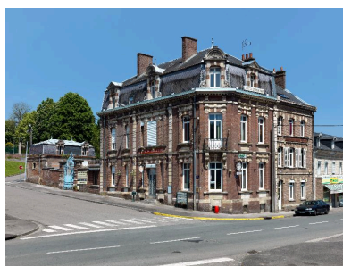
Vue d'ensemble. Phot. Thierry Lefébure IVR22_20138000083NUC2A
