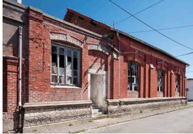
Vue de trois quarts. Phot. Hubert Bouvet IVR31_20136200129NUCA
