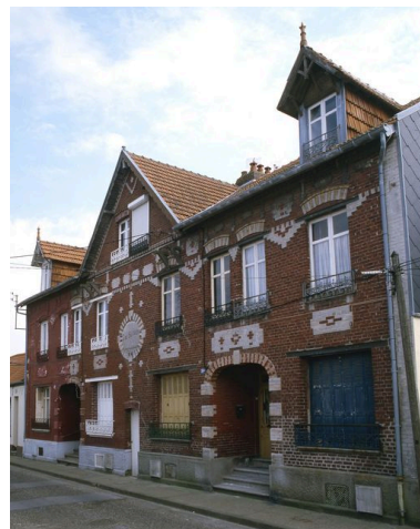
Maison à quatre logements accolés, Gai Séjour, rue Pasteur (1985 AR 39 à 42). Phot. Marie-Laure Monnehay-Vulliet IVR22_20068000133XA
