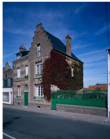
La villa entre mitoyens, villa Marguerite, 6 rue Carnot (1985 AT 77). Phot. Marie-Laure Monnehay-Vulliet IVR22_20028000052VA
