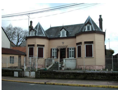
Gros-oeuvre recouvert d'un essentage de planches, villa des Roses, 16 rue Jules Verne (1985 AR 254). Phot. Elisabeth Justome IVR22_20058003725NUCA
