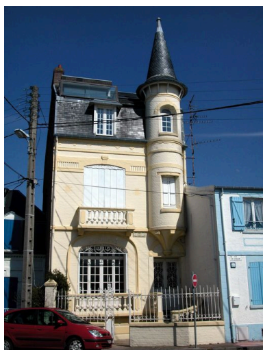
Tourelle sur l'angle en surplomb, maison dite La Coquette, 10 rue du Phare (1985 AT 236). Phot. Elisabeth Justome IVR22_20058003775NUCA
