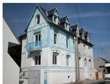
Faux pans de bois en ciment, 2 et 4 allée Beurivage (1985 AW 297, 298). Phot. Elisabeth Justome IVR22_20048001622NUCA
