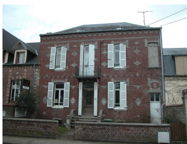
Maison avec couloir latéral pour accéder en fond de parcelle, Papillon bleu, 38 rue Carnot (1985 AV 130). Phot. Elisabeth Justome IVR22_20058003728NUCA
