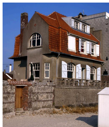
Vent Debout, de style régionaliste flamand, rue des Chalets (1985 AT 130). Phot. Marie-Laure Monnehay-Vulliet IVR22_20068000207XA
