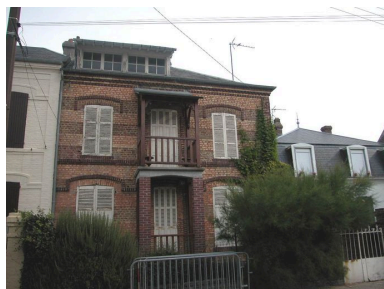
Gros-oeuvre à assises alternées, villa Picarde, 16 rue du Capitaine-Guy-Dath (1985 AV 207). Phot. Elisabeth Justome IVR22_20048001628NUCA
