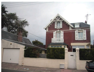
Garage à l'aplomb de la rue, 60 rue du Capitaine (1985 AW 145). Phot. Elisabeth Justome IVR22_20048001625NUCA
