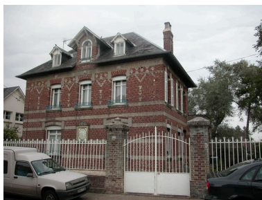
Appareil mixte formant motifs géométriques, 62 rue du Capitaine-Guy-Dath (1985 AW 149). Phot. Elisabeth Justome IVR22_20048001624NUCA
