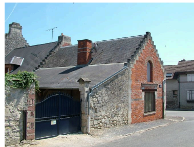
Vue postérieure. Phot. Irwin Leullier IVR22_20050200798NUCA
